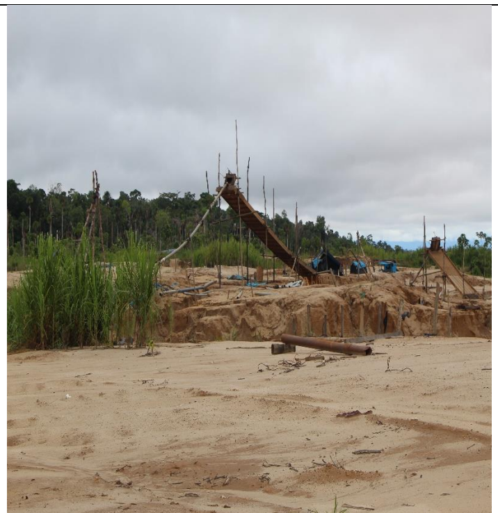
Actividad de dragado y lavado en canaletas de madera
