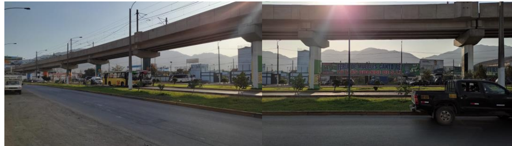
Figura 18. Vista de la Av. Próceres de la Independencia
