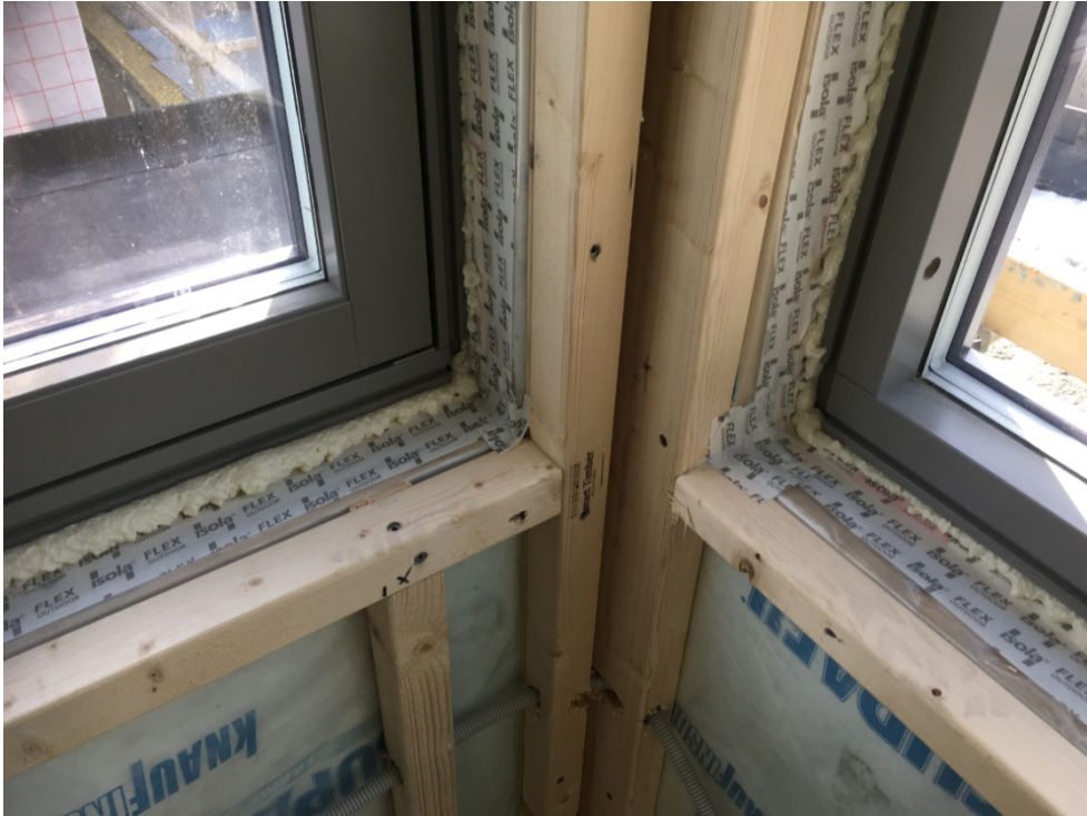
Figur 4.5. Tetning rundt innvendig side av vindu, hvor dampsperra er brettet inn i utsparingen, men ikke helt inn bak vinduskarmen. Den siste delen fra dampsperra og inn bak vinduskarmen er tettet med fleksibel teip. Selve monteringsfugen er skummet (mellom karm og dampsperre). Det er usikkert hvor godt skummet hefter mot teipen. Det er benyttet en dampåpen vindsperreteip, det vil si at man her kun oppnår en effekt på lufttetthet (ikke damptetthet hvis det er en hensikt). Foto: Stig Geving
