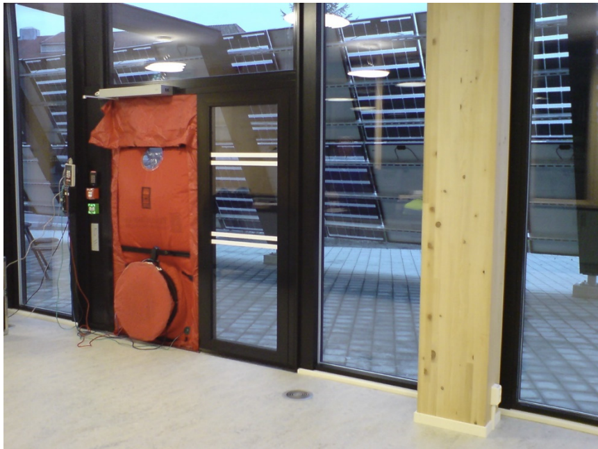
Figur 2.3. Måling av lekkasjetallet n_{50} ved hjelp av en «blower door» med vifte som settes inn i en ytterdør. Foto: Lars Gullbrekken, SINTEF Community
