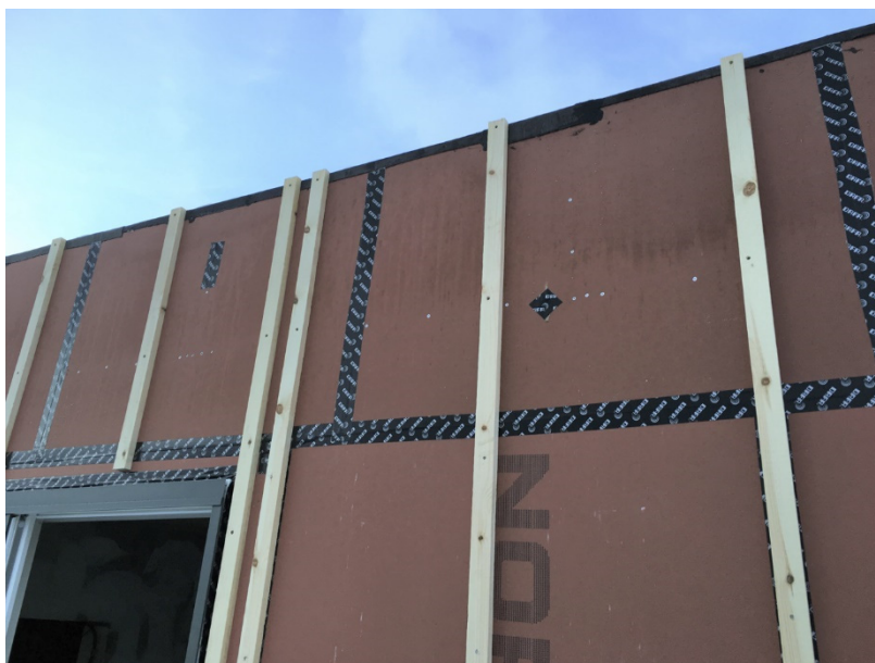
Figur 2.5. Eksempel på tetting av vindsperreskjøter med teip. Enkelte overflateskader på GU-plata er også blitt reparert med teip. Foto: Stig Geving, SINTEF Community
