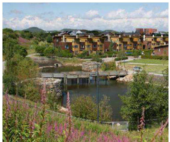
Fig. 22. Open stormwater dam in Sandnes, Rogaland (Åstebøl et al., 2013, Temablad 1).
