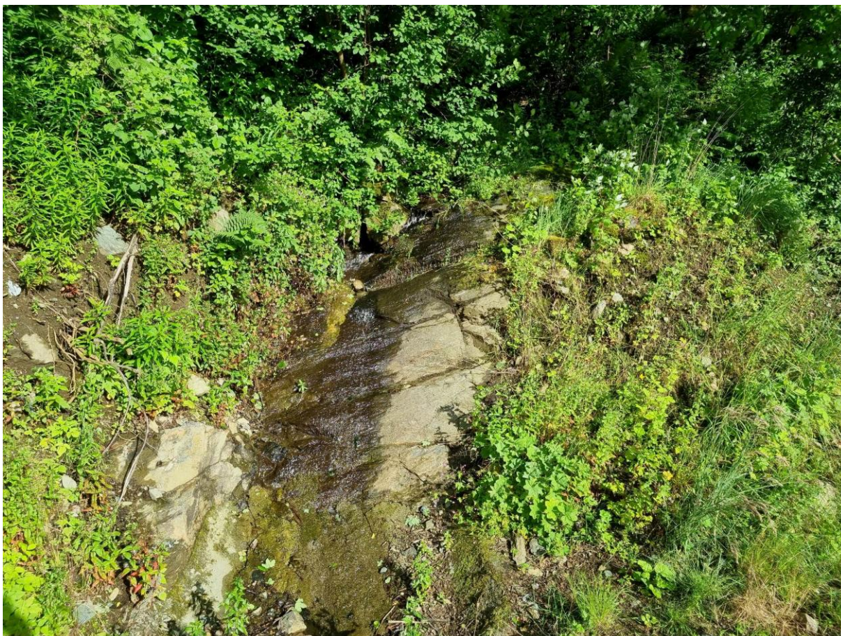
Figur 28: Dette bilde er fra yttergrensen fra Slettebakken ved ERT-profil 6 som viser en synlig blotning i dagen og et sted det renner vann ned til deponiområdet. Foto: Torvald Rosseland
