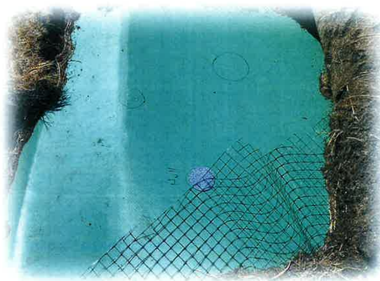
Lekkasjer på Sirakompassets tak finansieres ved bruk av fondsmidler i 2021.
