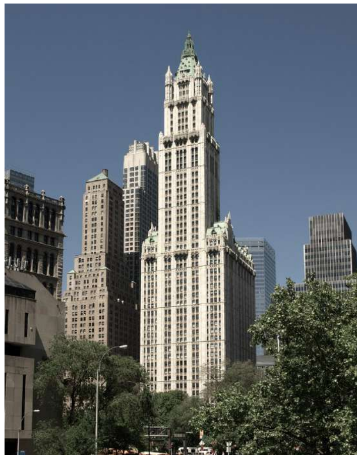
Figura 041 | Woolworth Building (Nova Iorque) em 1913
