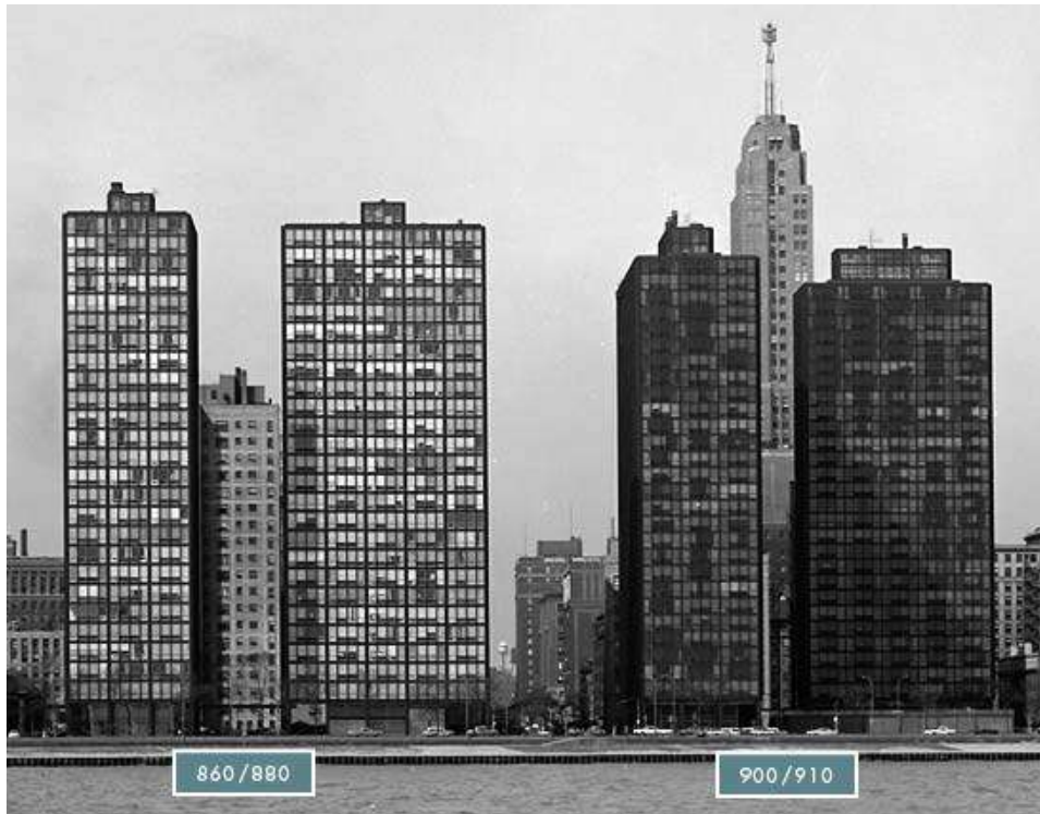
Figura 056 | Alçados do 860-880 Lake Shore Drive Apartments e do 900-910 North Lake Shore (em 1956), implantados lado a lado
