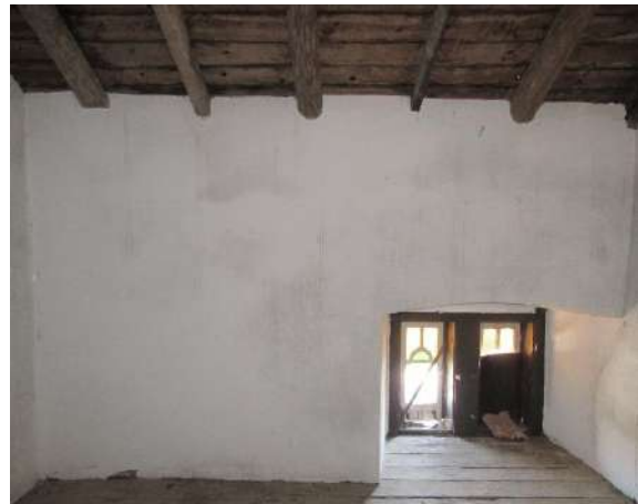
Fig.121: Piso 2 (devoluto) - Quarto (2) - Teto em barrotes de madeira e pavimento em soalho
