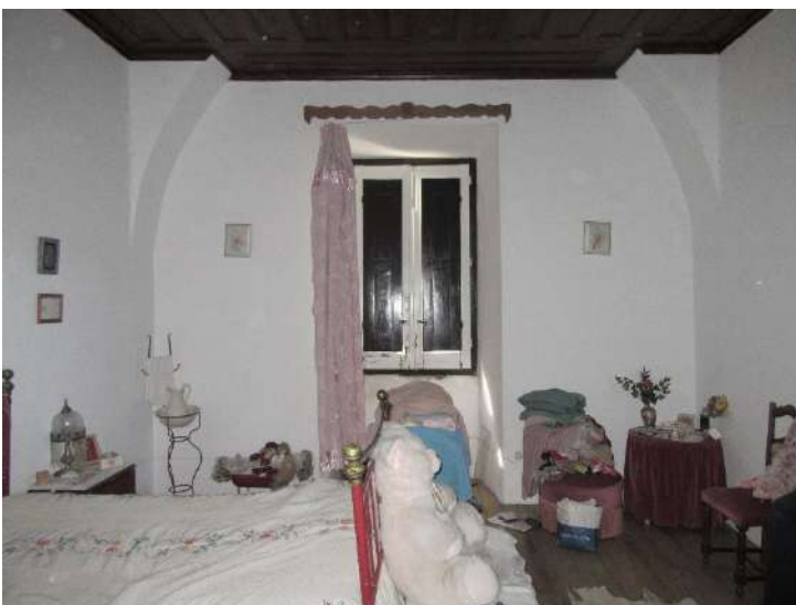
Fig.116: Piso 1 – Quarto (8) – Arco estrutural, soalho em madeira e teto saia-camisado
