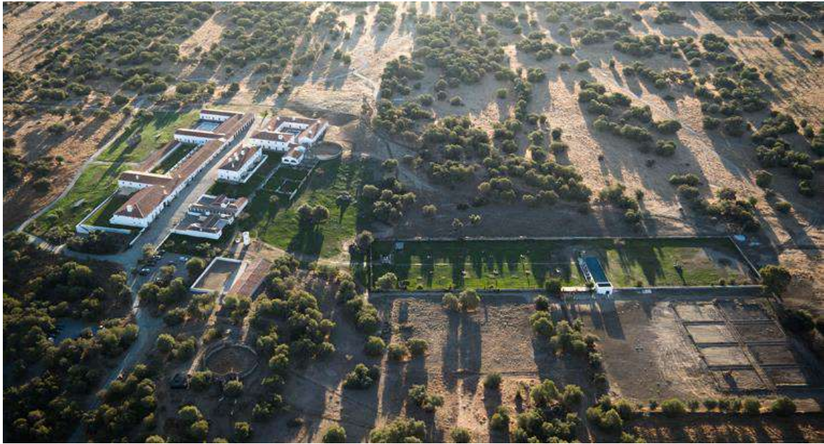
Fig.75: Vista aérea da herdade depois da intervenção
