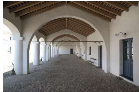
Fig.83 e 84: Alpendre de acesso aos quartos antes e depois da intervenção – conservação da estrutura (arcos pilares, paredes)
