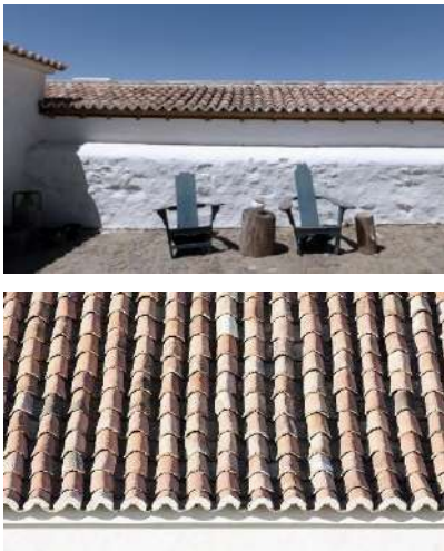
Fig.85 e 86: Exterior caiado a branco, textura das paredes e telha utilizada
