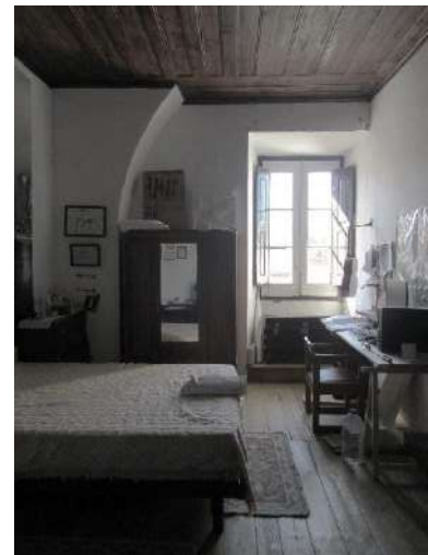
Fig.115: Piso 1 – Quarto (9) – Arco estrutural e soalho em madeira
