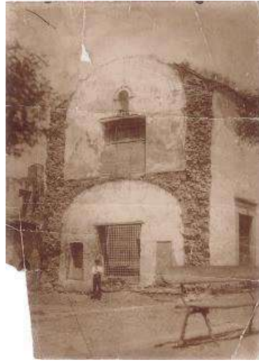
Fig.26: Abóbada de berço e paredes estruturais em alvenaria de pedra e terra visíveis na ruína do convento do Bom Jesus – data desconhecida
