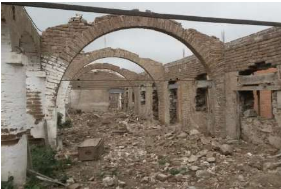
Fig.83 e 84: Alpendre de acesso aos quartos antes e depois da intervenção – conservação da estrutura (arcos pilares, paredes)
