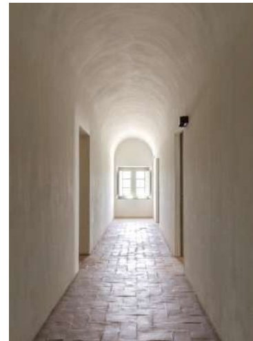
Fig.87 e 88: Interior – conservação das abóbadas, reboco com cal, revestimento em xisto e tijoleira tradicional de adobe
