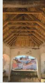
1 - Mirante - Estrutura Telhado
