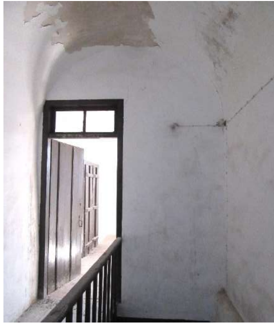
Fig.119: Piso 2 (devoluto) - Circulação horizontal (6) - Teto em abóbada e pavimento em tijoleira tradicional
