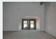
3 - Quarto - Pavimento e Janela
