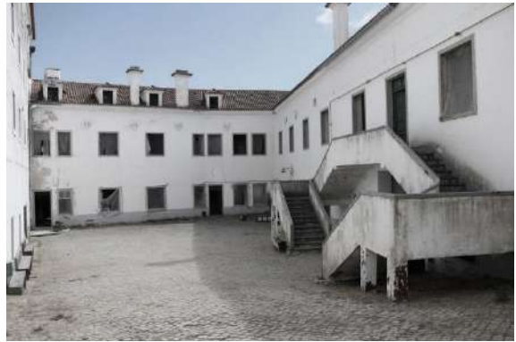
Fig.36: Convento de São Paulo antes da intervenção – Pátio interior (2016)
