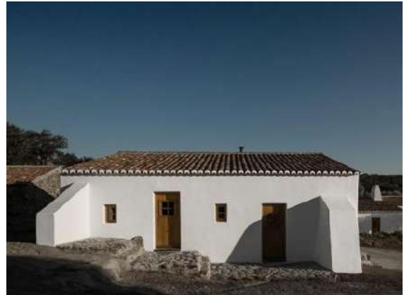
Fig.51: Fachada Poente Casa B após intervenção – contrafortes recuperados
