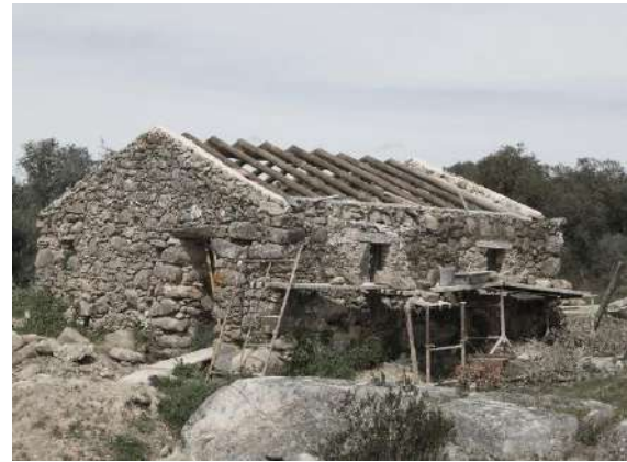
Fig.42: Estado de conservação antes da intervenção – casa de alvenaria de pedra à vista (casa A)
