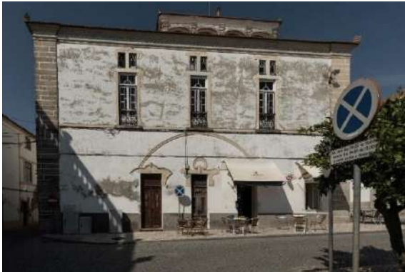
Fig.12: Alçado principal da Casa do Mirante - Nascente
