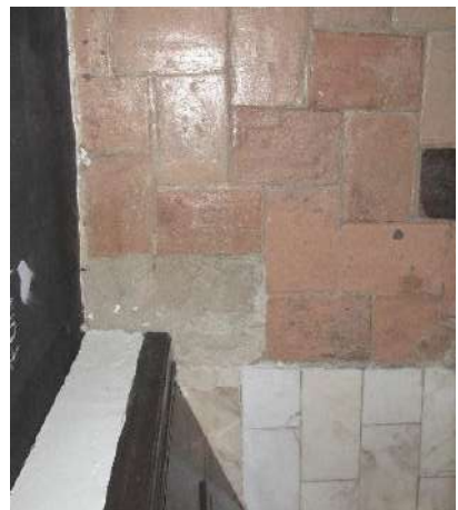
Fig.18: Revestimentos em tijoleira tradicional e mármore – suíte piso 1
