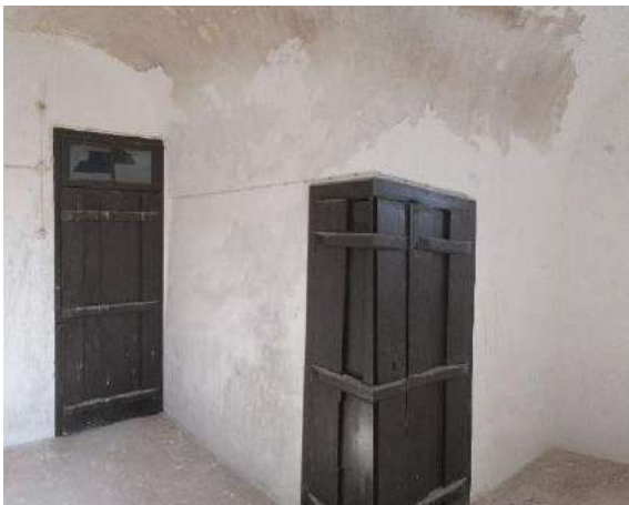
Fig.120: Piso 2 (devoluto) - Átrio (5) - Teto em abóbada e pavimento em tijoleira tradicional
