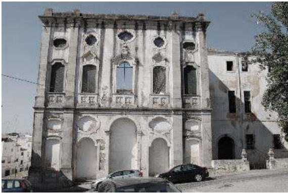
Fig.35: Convento de São Paulo antes da intervenção (2016)
