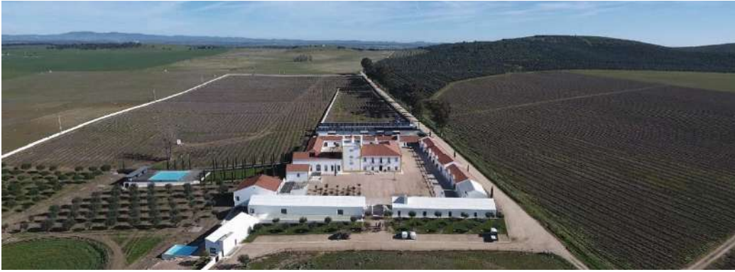
Fig.63: Vista aérea da Herdade depois da intervenção
