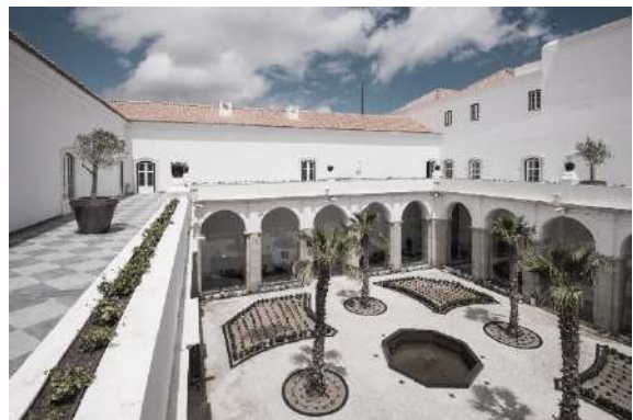
Fig.38: Convento de São Paulo depois da intervenção – Pátio interior (2019)
