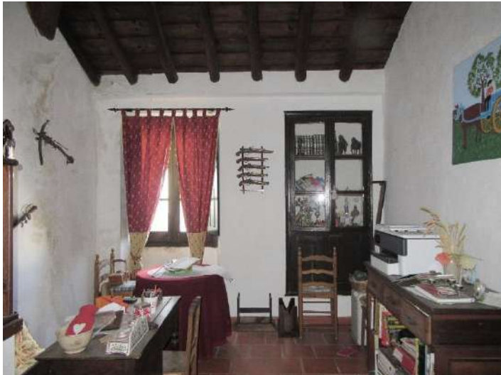
Fig.111: Piso 1 – Escritório (10) – Teto em barrotes de madeira
