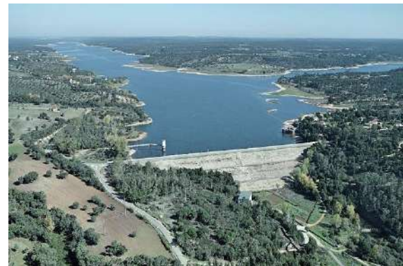
Fig.34: Barragem de Montargil
