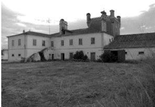
Fig.66: Fachada Norte do volume principal da herdade antes da intervenção
