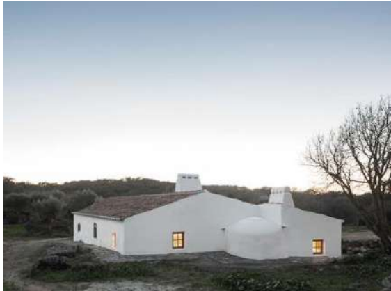
Fig. 54: Fachadas Norte e Nascente casa C após intervenção
