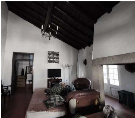
Fig.110: Piso 1 – sala (11) – Teto em barrotes de madeira e lareira
