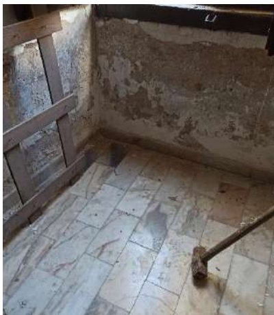
Fig.16: Pavimento em mármore – Antiga capela, piso 0
