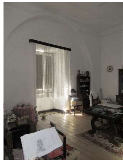
Fig.117: Piso 1 – Quarto (9) – Arco estrutural e soalho em madeira
