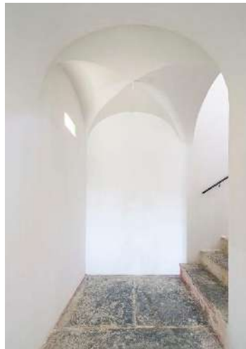
Fig.87 e 88: Interior – conservação das abóbadas, reboco com cal, revestimento em xisto e tijoleira tradicional de adobe
