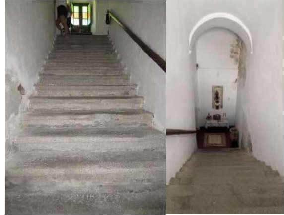
Fig.109: Circulação vertical - acesso ao piso 1 – Escada em granito e teto em abóbada
