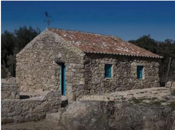
Fig.48: Fachadas Sul e Nascente Casa A após intervenção
