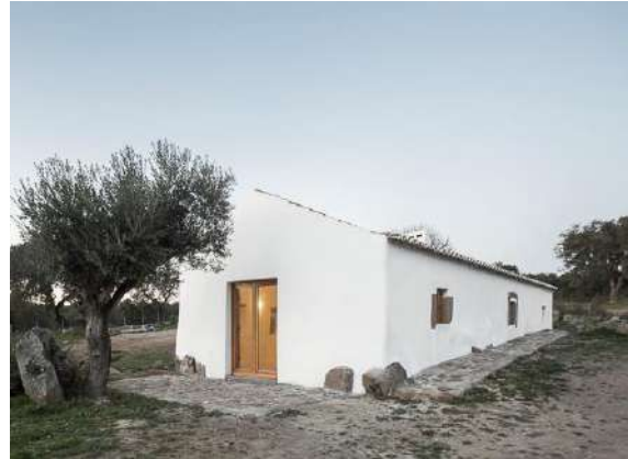
Fig. 55: Fachadas Sul e Nascente casa C após intervenção
