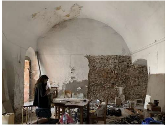
Fig.107: Piso 0 – Capela (5) – Arcos estruturais
