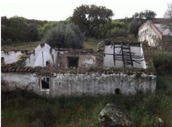
Fig.43: Estado de conservação antes da intervenção – casa maior (casa B)
