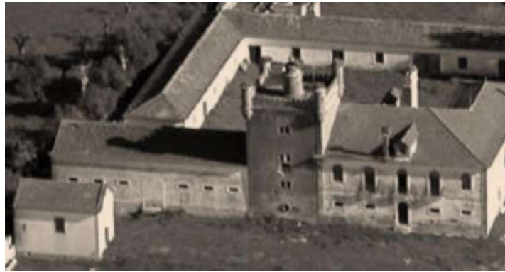
Fig.64: Capela, celeiro, torre central e casa principal antes da intervenção – Fachada Sul
