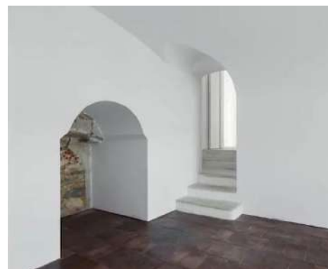
Fig.71: Materialidade antes e depois da intervenção – revestimento a tijoleira tradicional e mármore, reboco com base de cal, arcos e abóbadas conservados – torre
