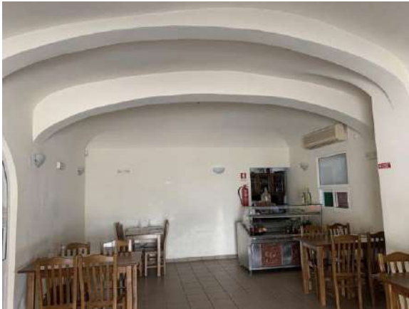
Fig.108: Piso 0 – Restaurante (7) – teto em abóbadas
