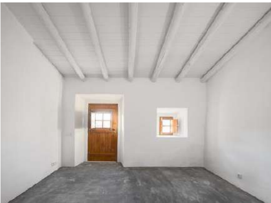
Fig.58: Pavimento em cimento afagado, paredes caiadas, vãos com madeira de pinho e tetos com barrotes de madeira pintados de branco (casa B)
