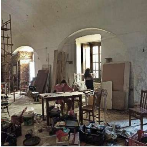
Fig.106: Piso 0 – Capela (5) – teto em abóbada
