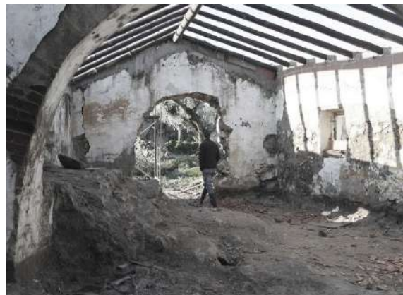
Fig.44: Estado de conservação antes da intervenção – moinho (casa C)
