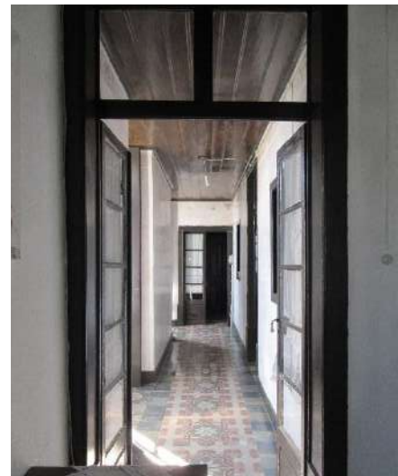
Fig.112: Piso 1 – Circulação horizontal (3) – Acesso à cozinha
