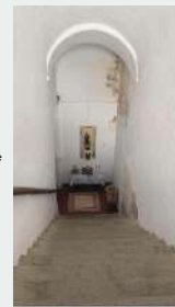
Circulação Vertical e Abóbada de Berço
