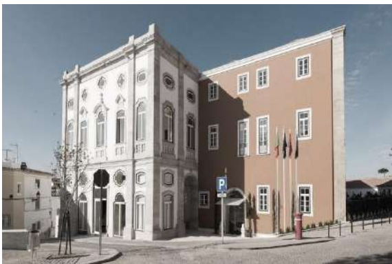
Fig.37: Convento de São Paulo depois da intervenção (2019)
