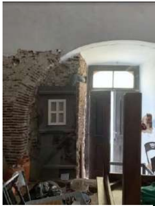
Fig.14: Arco estrutural em tijolo de maciço barro – Antiga capela, piso 0
