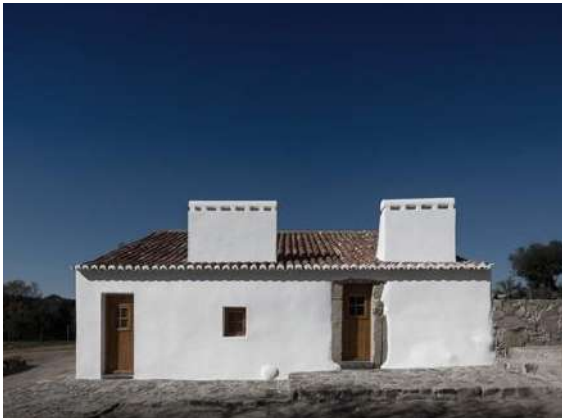
Fig.50: Fachada Nascente Casa B após intervenção – forte presença das chaminés
