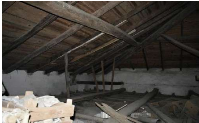
Fig.15: Área da estrutura do telhado – piso 2
