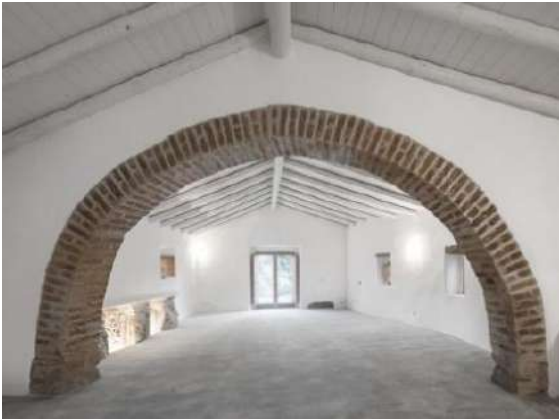
Fig.56: Interior casa C após intervenção - arco em tijolo maciço aparente
