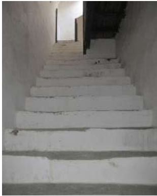
Fig.118: Circulação vertical - Acesso ao piso 2 e 3
