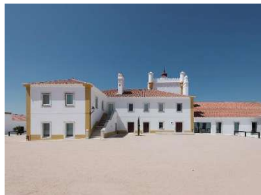
Fig.67: Fachada Norte do volume principal da herdade depois da intervenção
