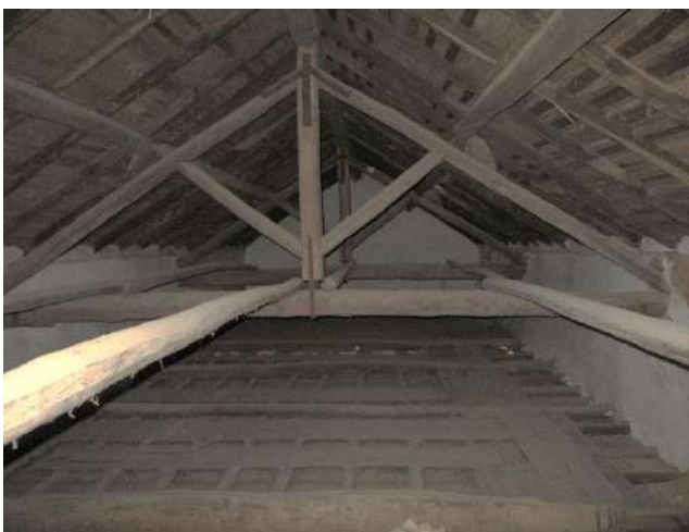
Fig.122: Piso 2 (devoluto) - Espaço vazio (4) - Estrutura do telhado
