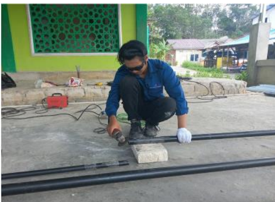
Gambar 7. Proses pemotongan material
