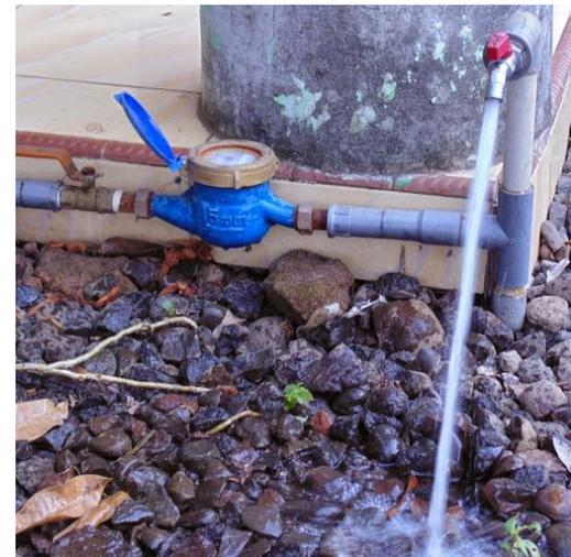
**Gambar 3.16 Pemasangan pipa rumah dan meteran pencatat air**
