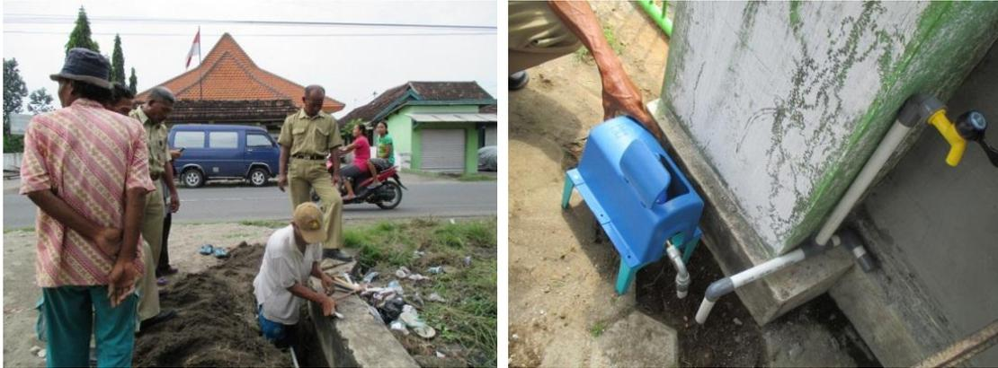
**Gambar 1.5** Proses penyambungan sambungan rumah atau SR di desa Balongdowo
