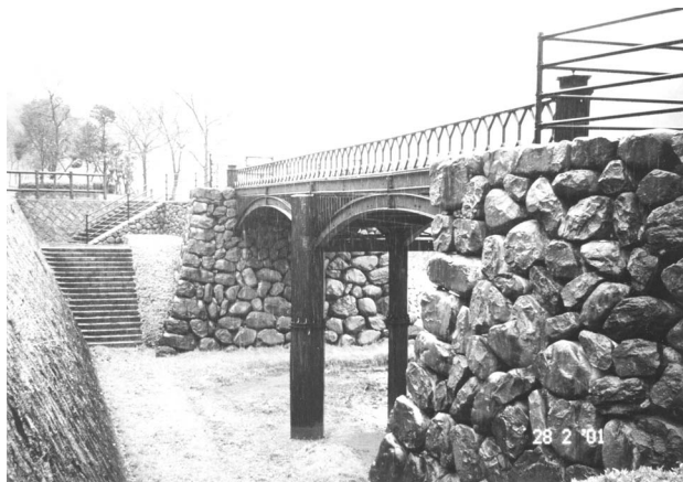
写真3-1 羽淵鑄鉄橋(撮影：種田)
