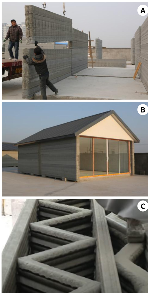
Figura 1: (a) Montagem de parede, (b) casa finalizada e (c) estrutura do elemento pré-fabricado. Fonte: Walker (2014).
