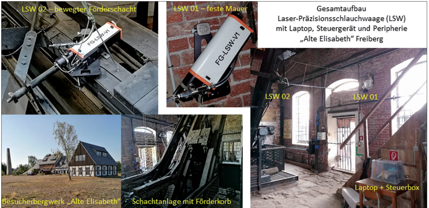
Abb. 19: Anwendungsgebiet Förderschacht-Monitoring „Alte Elisabeth“ Freiberg
