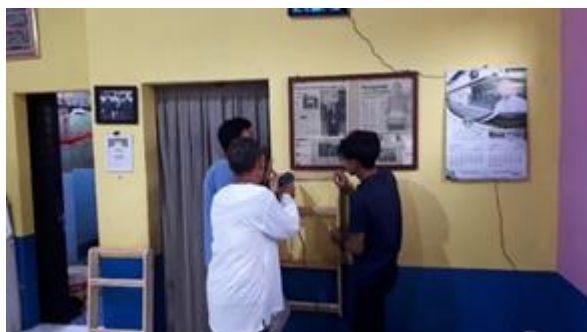
Gambar 3. Pemasangan Rak Buku
