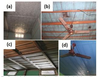
Fig. 7— (a) & (b) woven bamboo ceiling (c) & (d) timber ceiling
