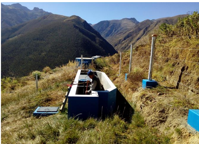
Figura 11 – Cámara de rejillas - desarenador.
