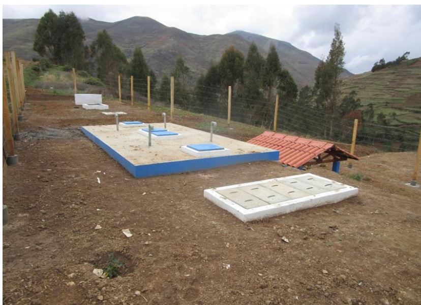
Figura 9 – Tanque séptico baffled.
