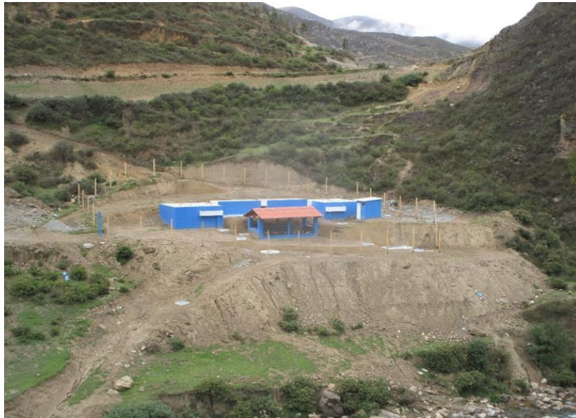
Figura 10 – PTAR del Anexo de Pichuynioc.
