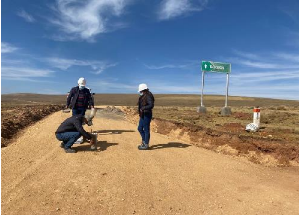
Fotografía 11: Vista de los trabajos realizados en el camino vecinal de Batacancha.
