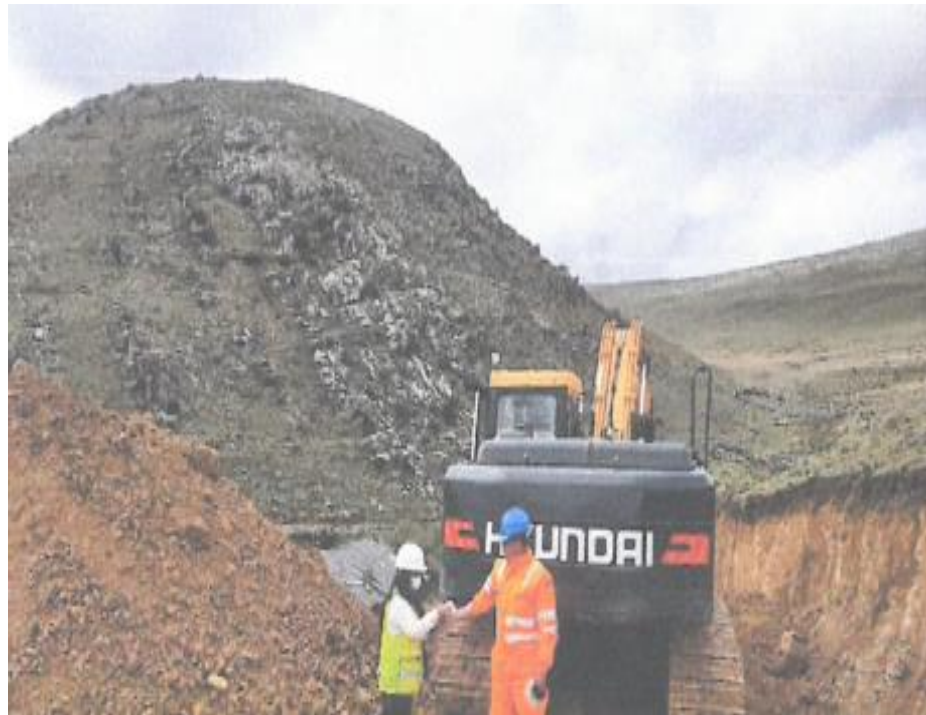
Fotografía 02: En la imagen se visualiza el proceso de inspección de la cantera B (arena) en la Progresiva 0+751, sector Batacancha.
