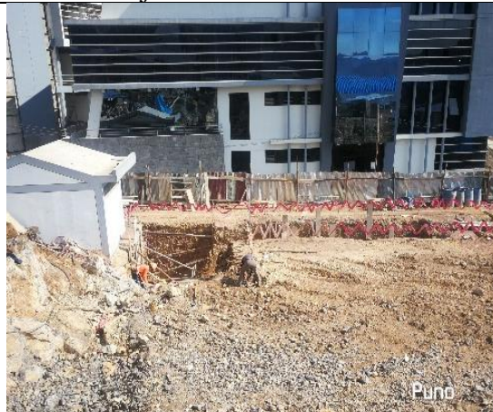
Excavacion en la caseta de electrificacion existente
