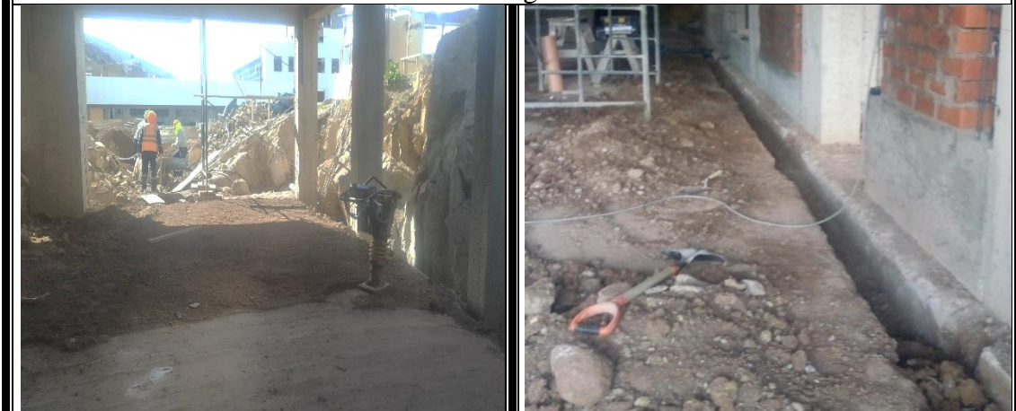
Trabajos de Relleno, nivelacion y compactado
