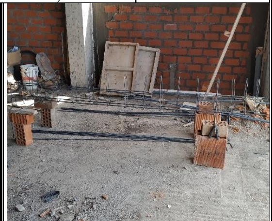
Habilitado de acero para columnas arriostre y vigas de confinamiento
