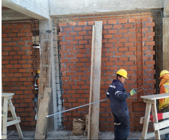
Colocado de acero en columnas de arrioste y vigas de confinamiento
