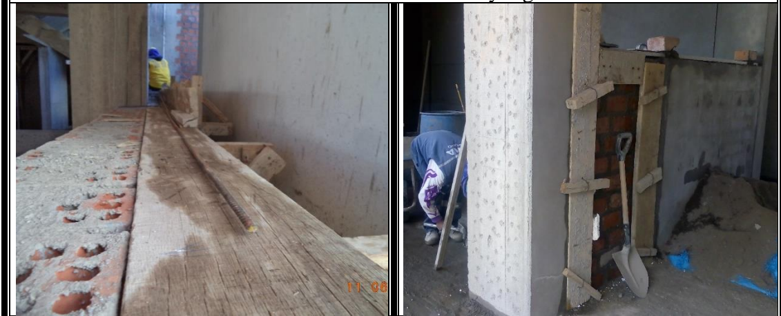
Encofrado de columnas de arriostre y vigas de confinamiento
