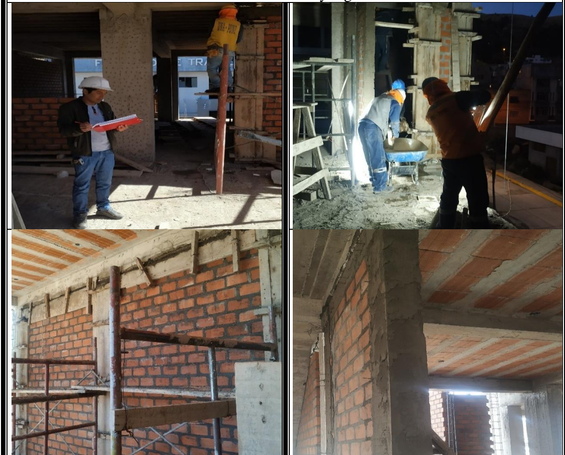
Colocado de concreto en columnas de arrioste y vigas de confinamiento
