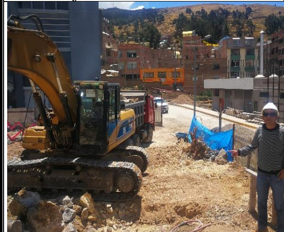
Eliminacion de Material excedente
