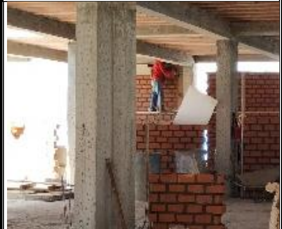
Colocado de Tecnopor (Poliestireno) de 1" de espesor
