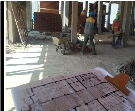
Limpieza del area del trabajo
