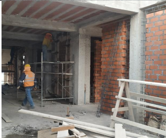
Colocado de acero en columnas de arrioste y vigas de confinamiento
