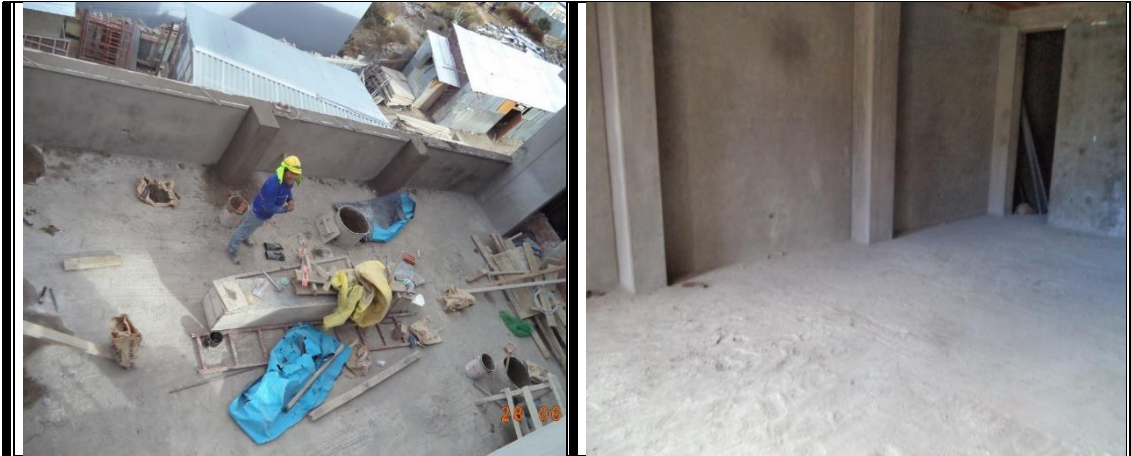
Tarrajeo en muros interiores
