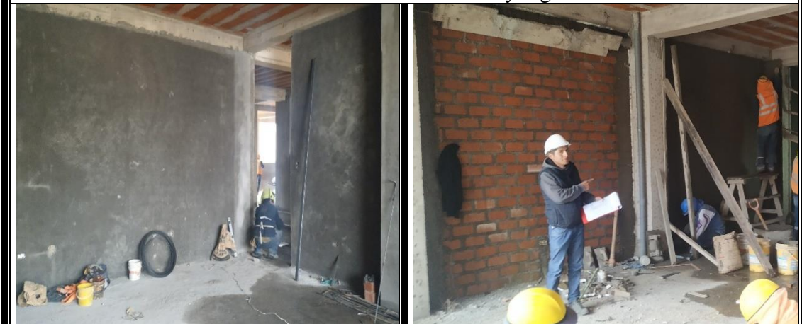
Tarrajeo en muros interiores
