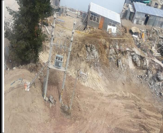
Eliminacion de Material Excedente
