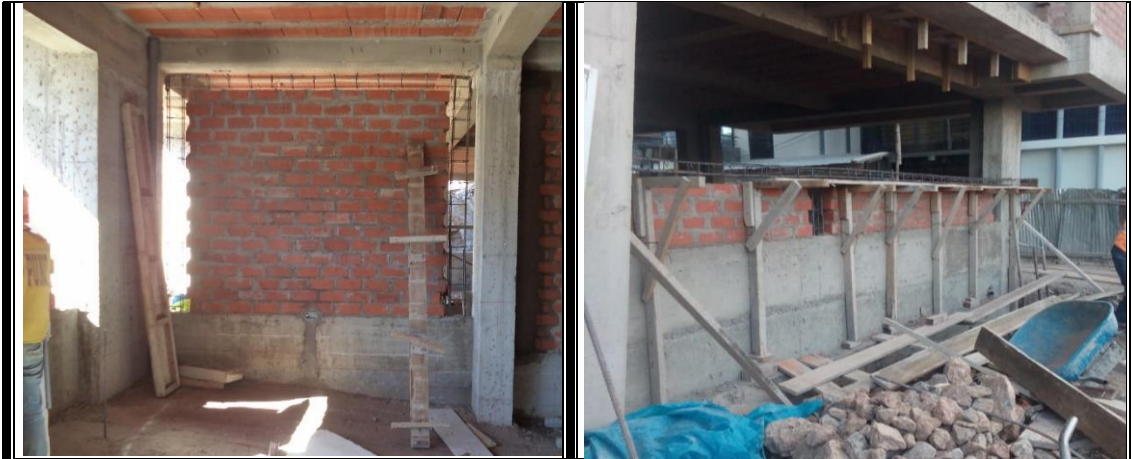
Colocación de Acero en columnas de arriostre y vigas de confinamiento
