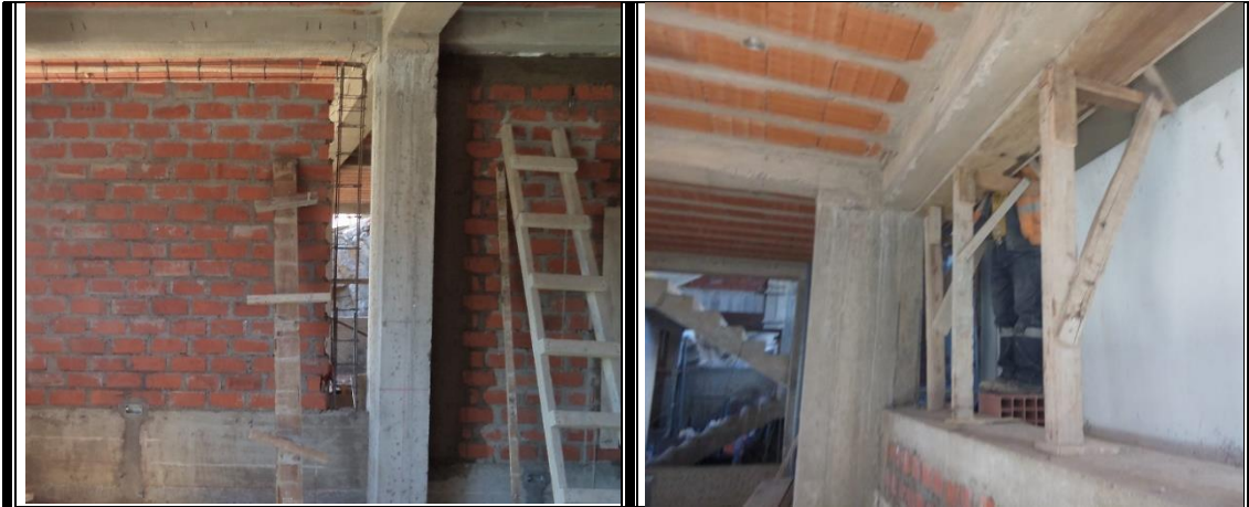
Colocado de concreto en columnas de arriostre y vigas de confinamiento
