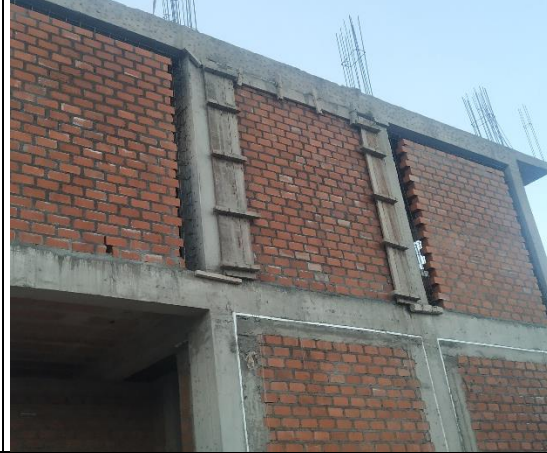
Colocado de acero en columnas de arrioste y vigas de confinamiento
