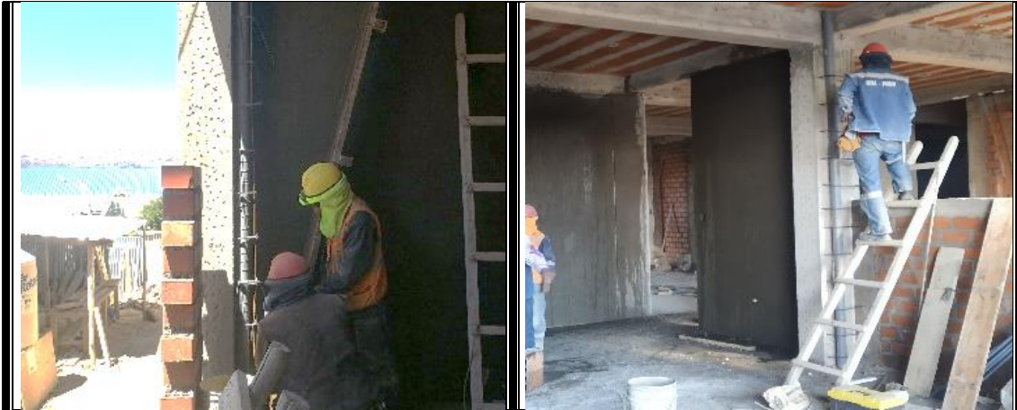
Acero y encofrado de columnas sanitarias
