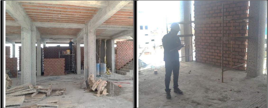
Asentado de Muro en el Segundo Nivel
