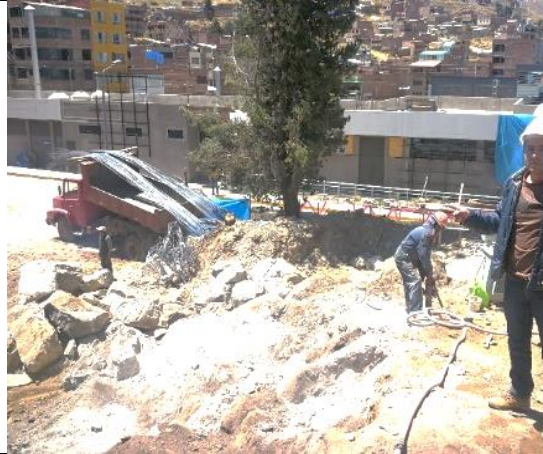
Trabajos no contemplados en el Expediente Técnico: Voladura de Roca
