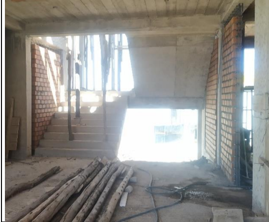
Asentado de muro en el cuarto nivel
