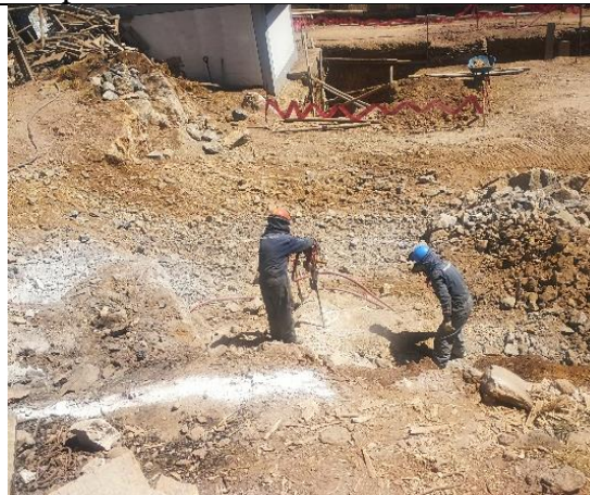
Trabajos de voladura de Roca
