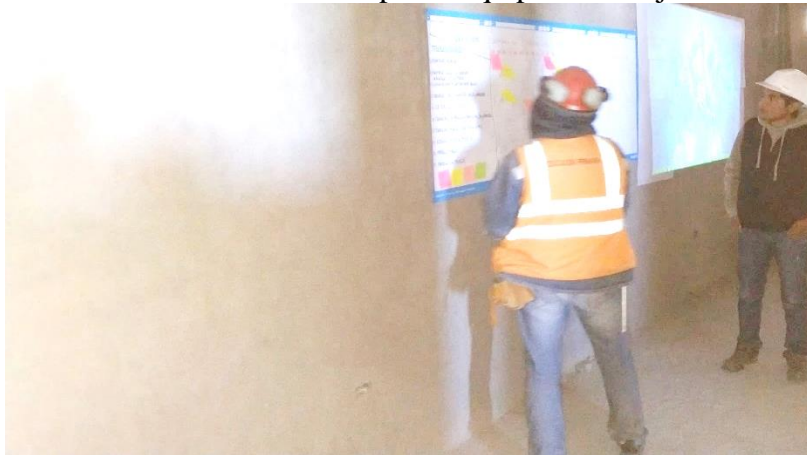
Figura N° 54: Se observa el colocado de los pos'it de del personal de obra de acuerdo a su especialidad.
