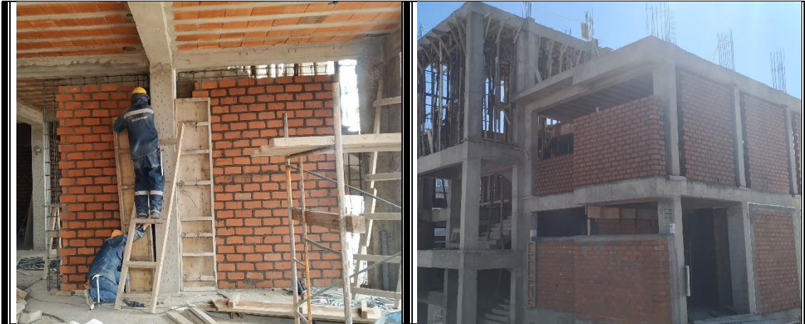
Encofrado de columnas de arrioste y vigas de confinamiento
