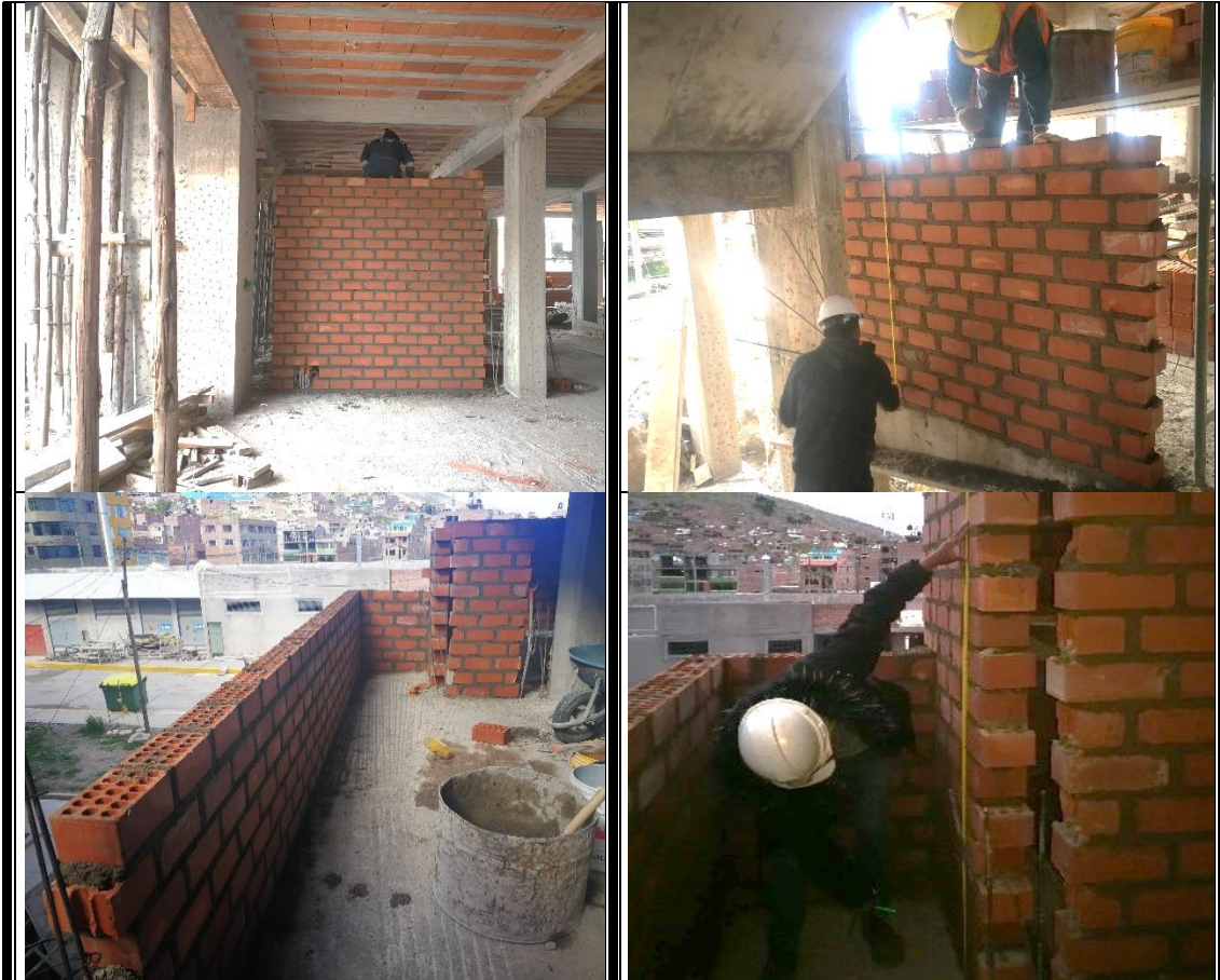
Asentado de Muro en el tercer nivel
