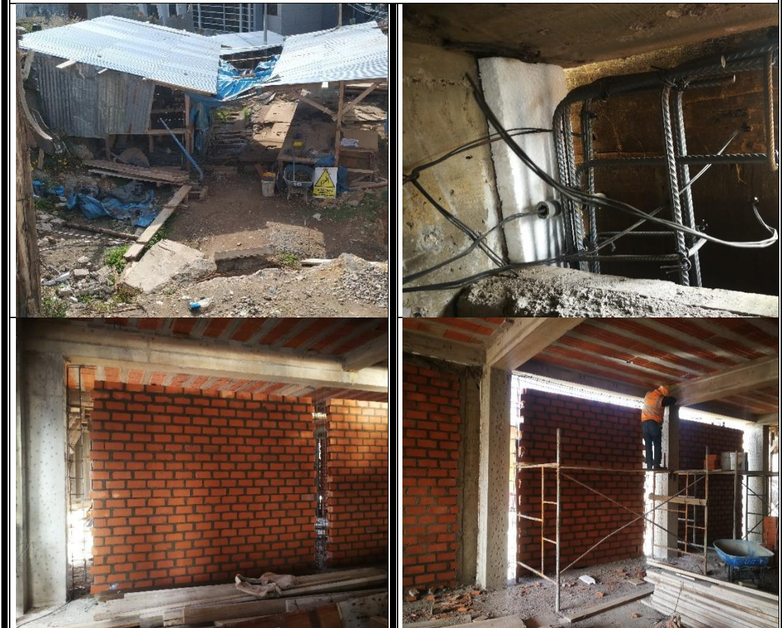
Asentado de Muro en el tercer nivel
