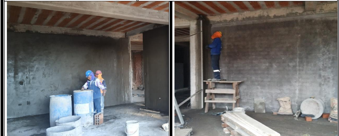
Tarrajeo de vigas y columnas
