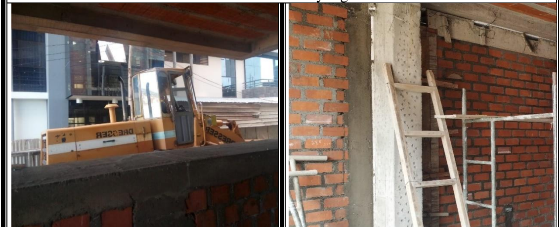
Encofrado de columnas de arriostre y vigas de confinamiento
