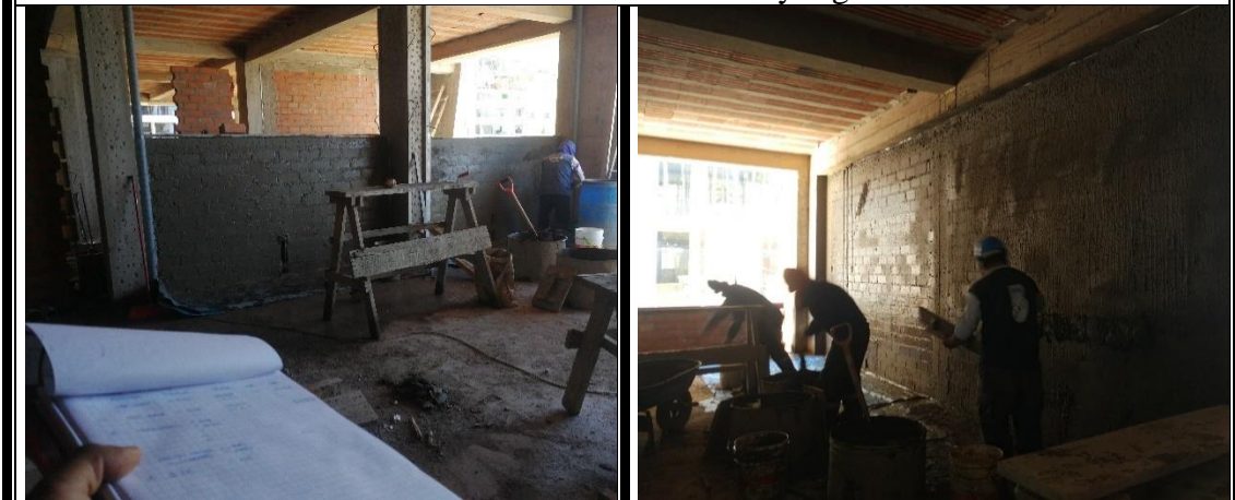
Tarrajeo en muros interiores
