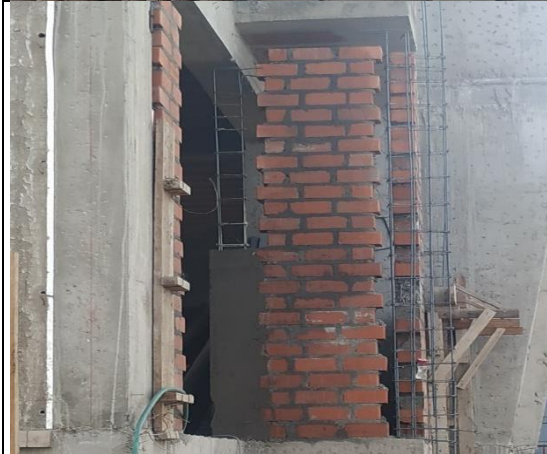
Colocado de acero en columnas de arrioste y vigas de confinamiento
