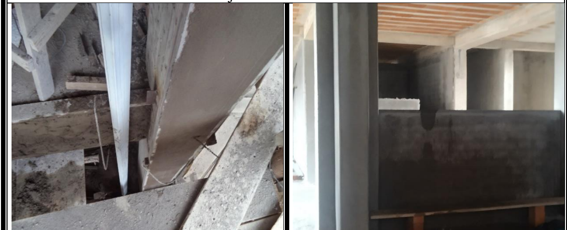
Tarrajeo de vigas y columnas
