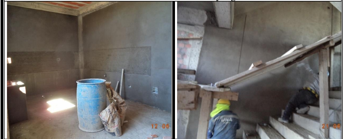
Tarrajeo en muros interiores
