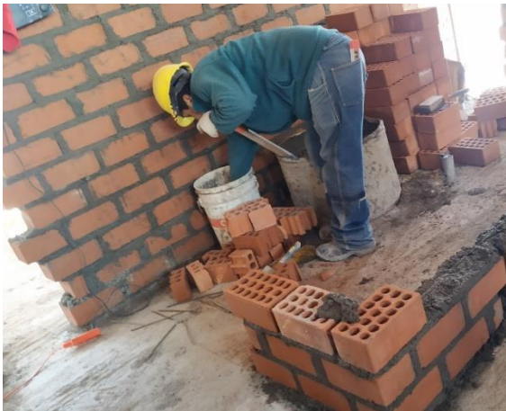
a) Asentado de ladrillo (Trabajo productivo)
