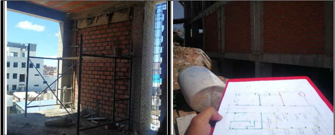
Colocado de concreto en columnas de arrioste y vigas de confinamiento
