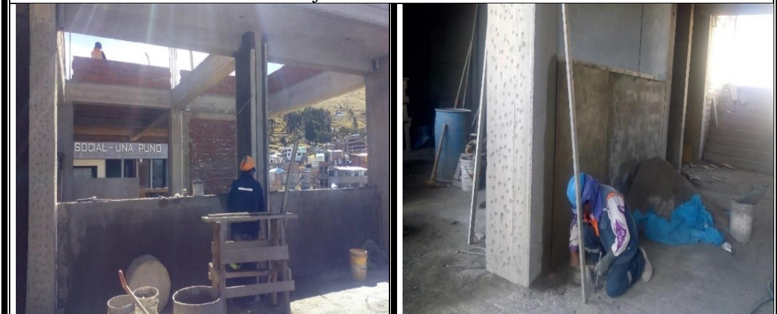
Tarrajeo de vigas y columnas
