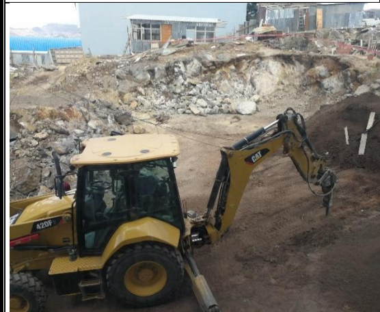
Trabajos de Demolicion de Roca
