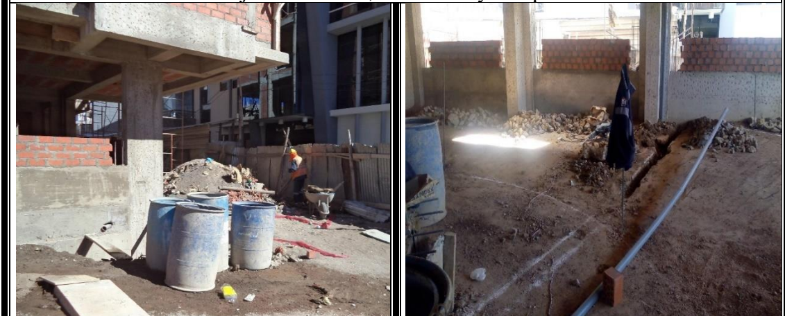
Asentado de Muros en el Primer nivel
