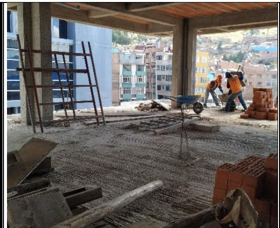
Habilitado de andamio tipo acero y traslado de ladrillo
