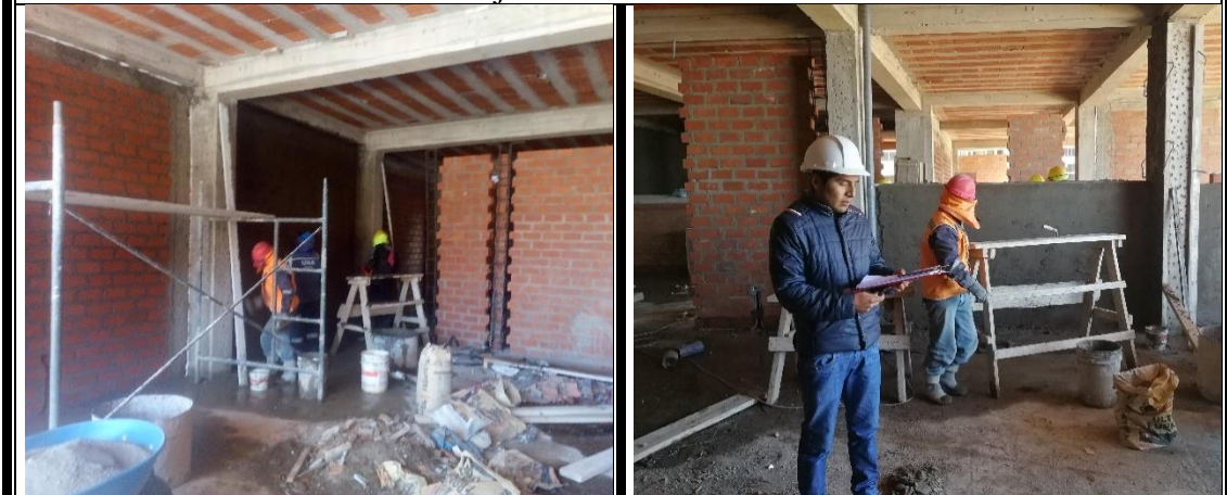
Tarrajeo de vigas y columnas
