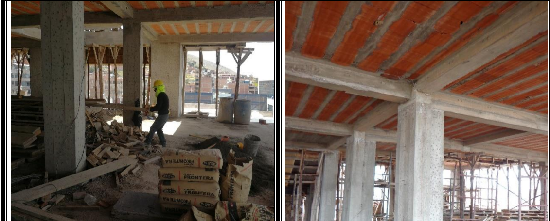
Desencofrado de Losa aligerada del cuarto nivel
