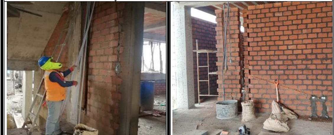
Canalización y entubado en Instalaciones sanitarias
