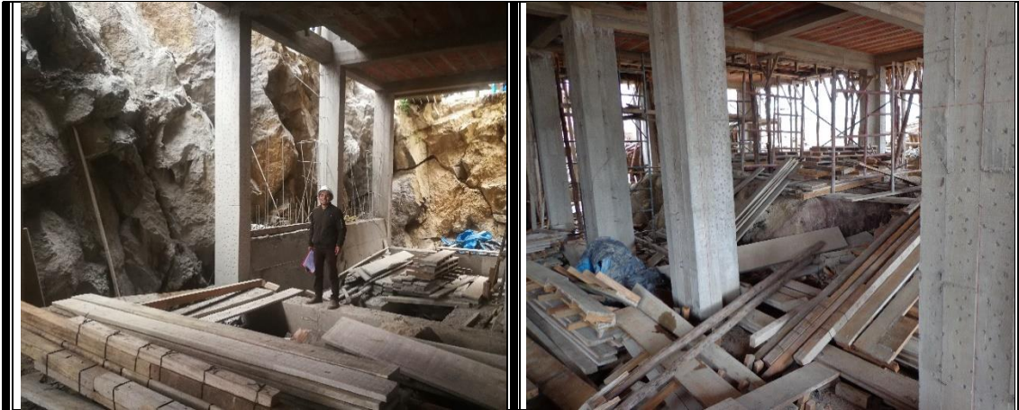
Desencofrado de Losa aligerada del Primer nivel
