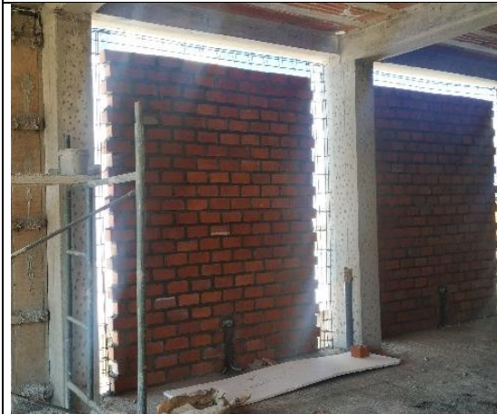
Colocado de Tecnopor (Poliestireno) de 1" de espesor
