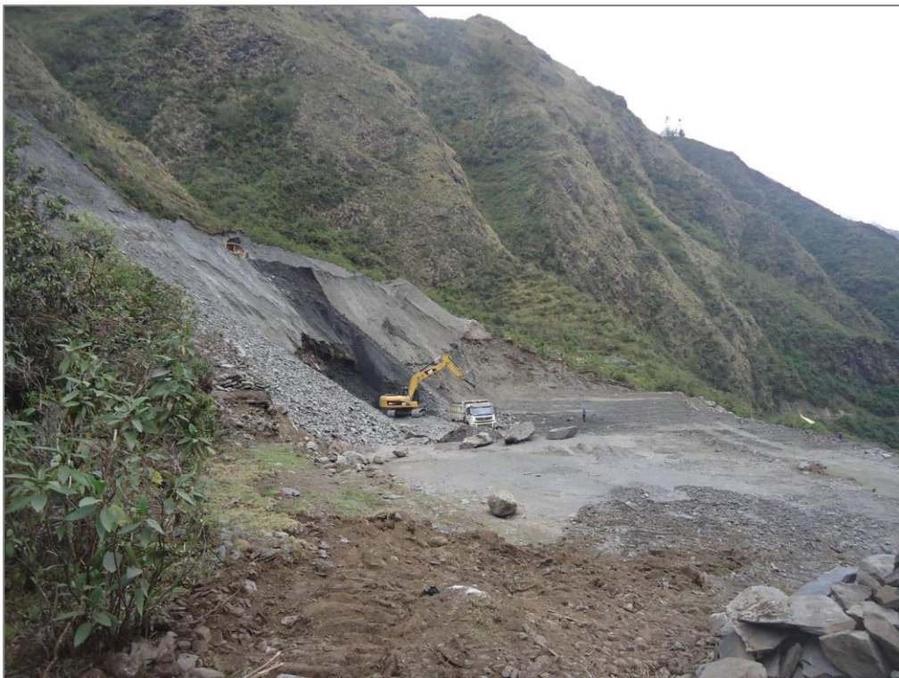
Fotografía N° 1 Vista de frente del talud durante el proceso constructivo.
