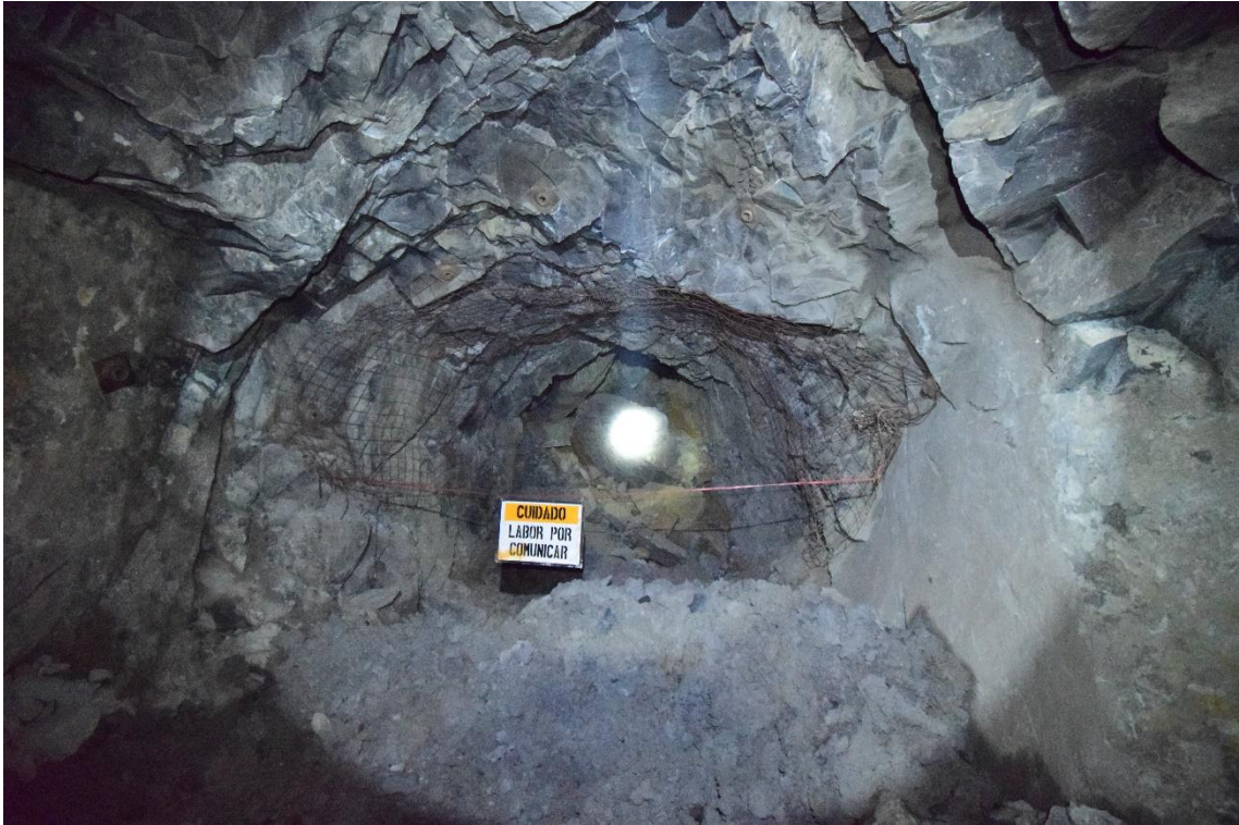
Figura 3: Ventana de explotación N° 04 NW, desde el By Pass 218 NW Nv.3285. Se puede apreciar una calidad de roca regular III-A.
