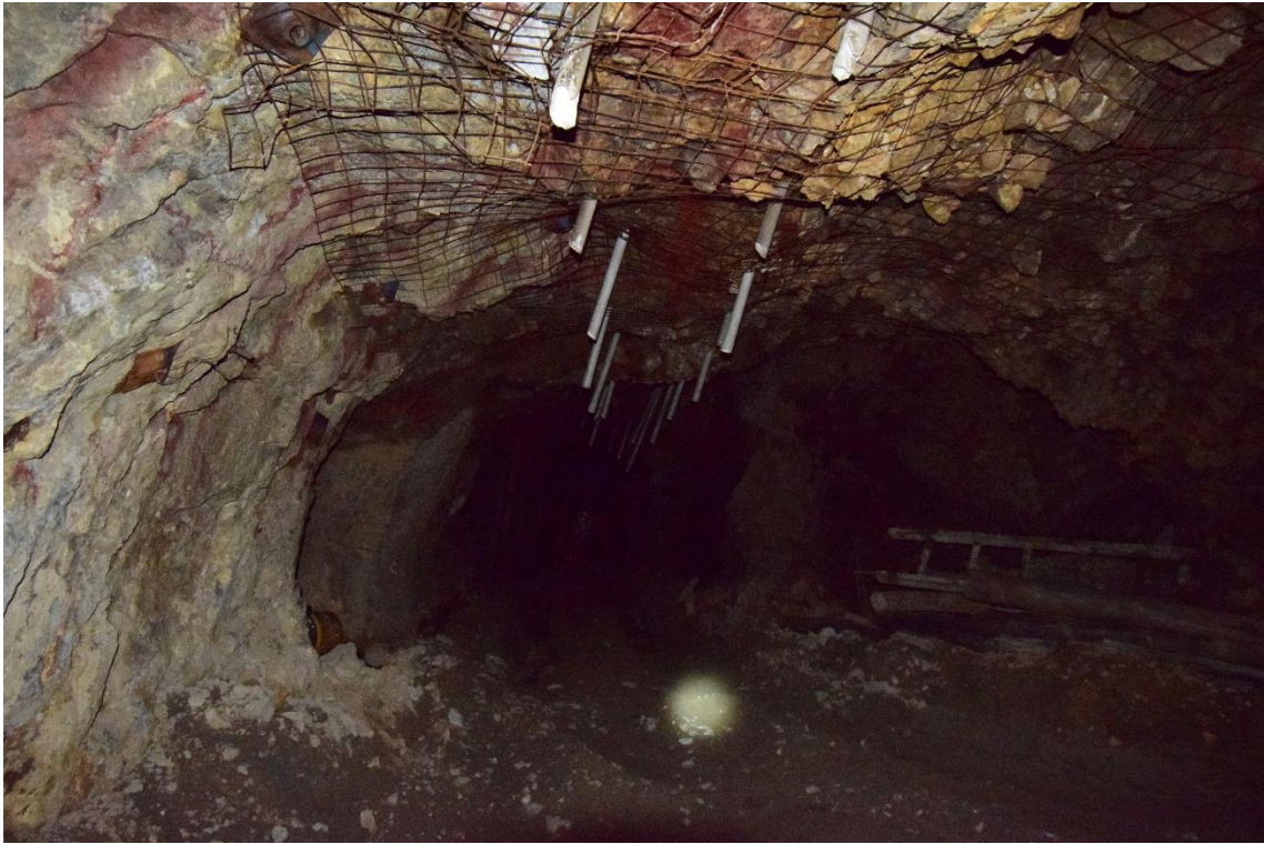
Figura 1: Galería 190 NW Nv. 3240, taladros largos positivos perforados, para la recuperación de pilares puente y relleno económico.
