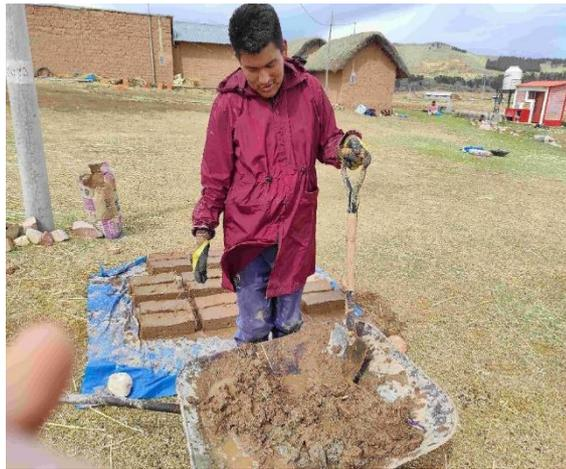
**Figura 30:** Mezcla estabilizada con cemento.
