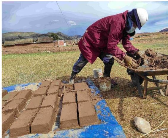
**Figura 31:** Moldeo de adobes estabilizados con cemento.
