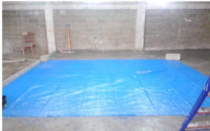
Figura 5. Manta de polipropileno usada para proteger el suelo durante la segregación de residuos
