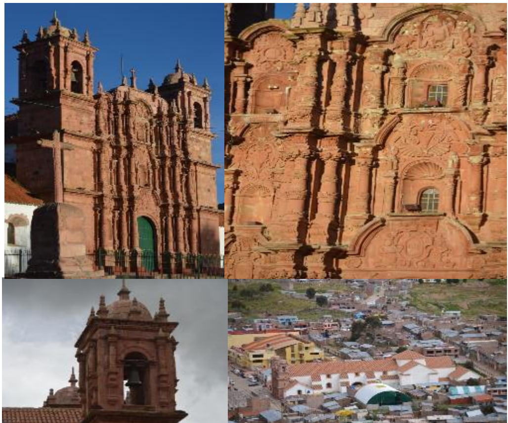
Figura 16. Detalles externos, el frontis del templo de Asillo.
