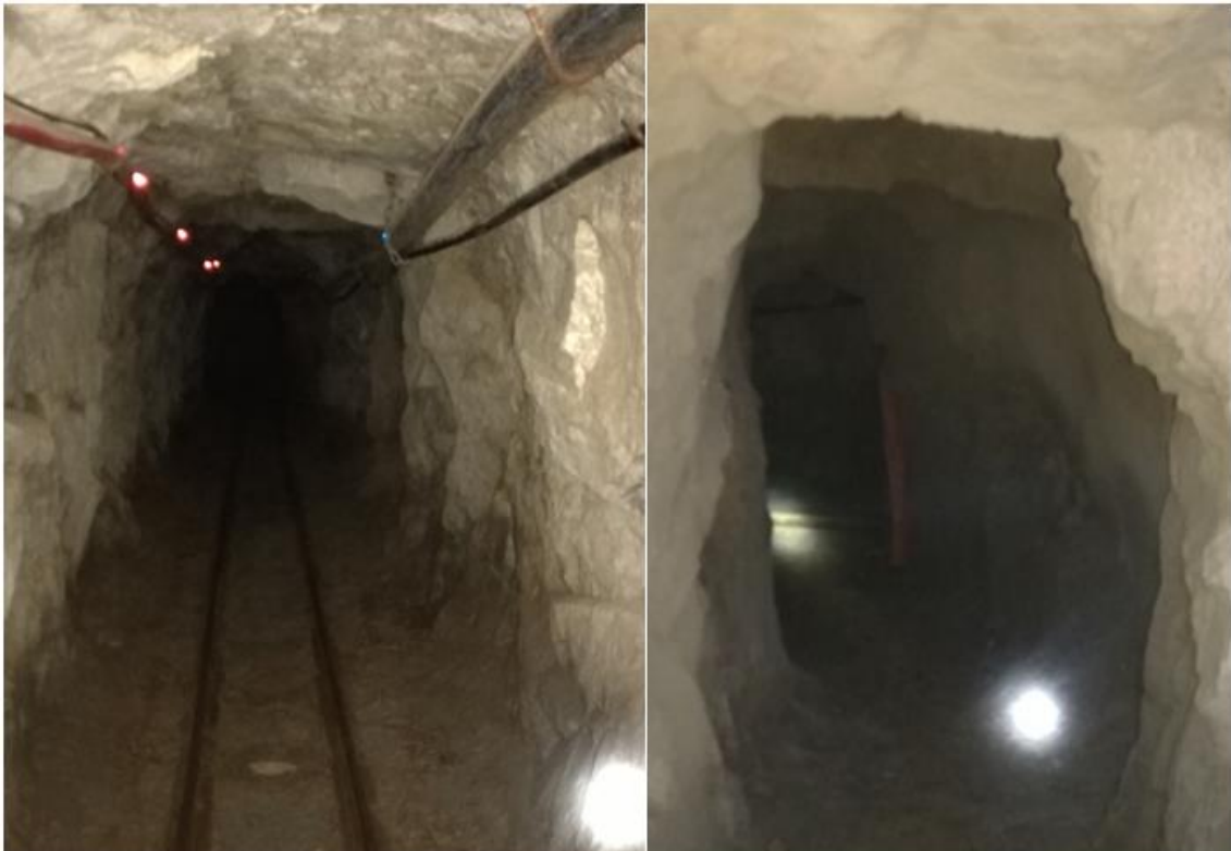
Figura 66: Ambientes diáfanos de las labores: GL 508 E y CX 365W.
