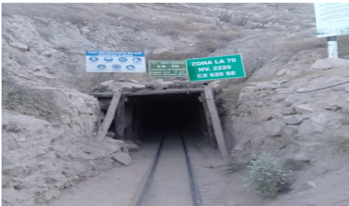
Figura 37: Bocamina principal de la zona 70 de la mina Alpaca.
