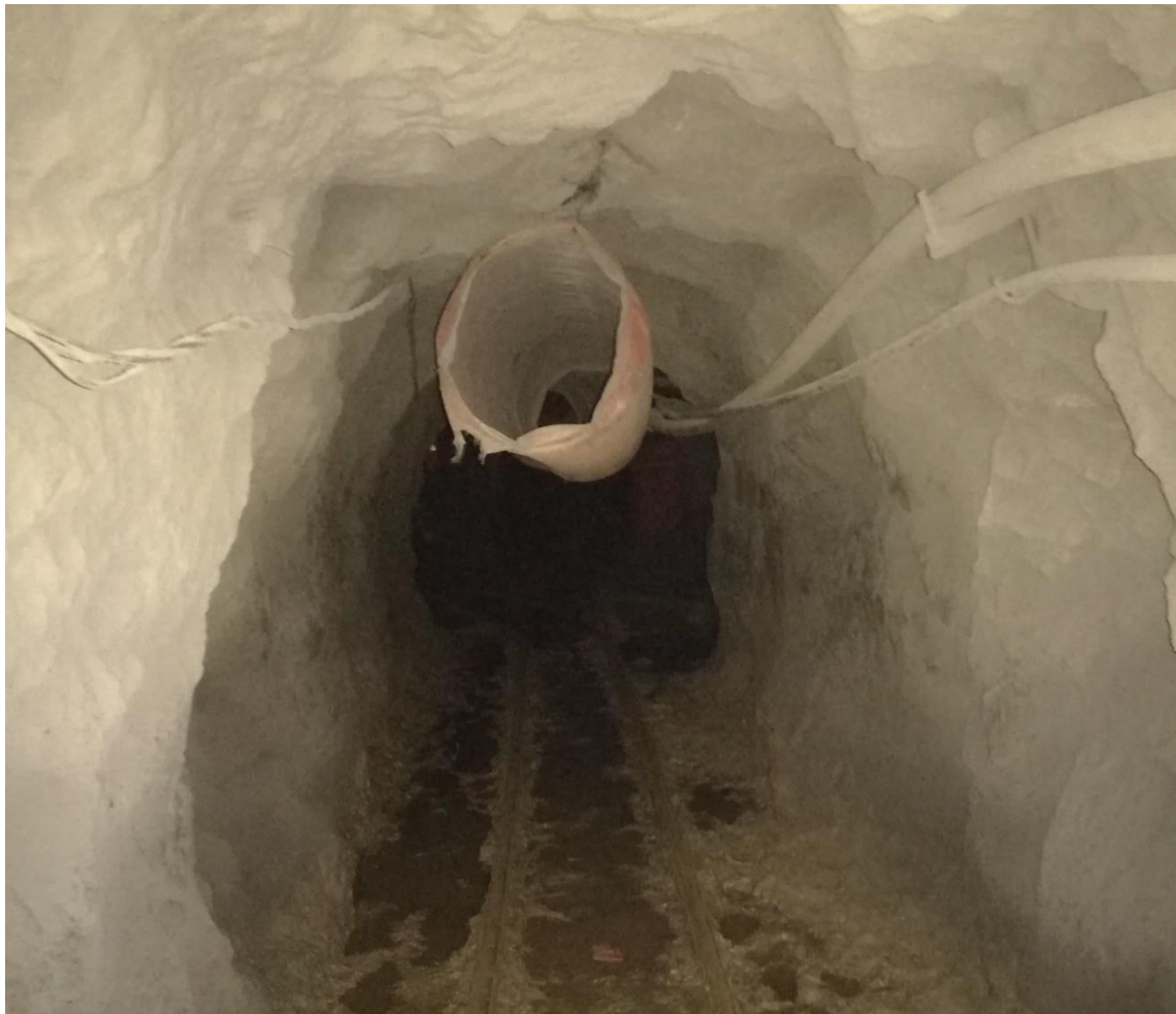
Figura 64: Instalación de mangas de 24” de diámetro CX 540 W.
