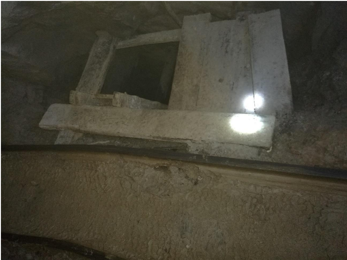
Figura 49: Vista de la Chimenea 920 cuando se construía la Galería V-03.
