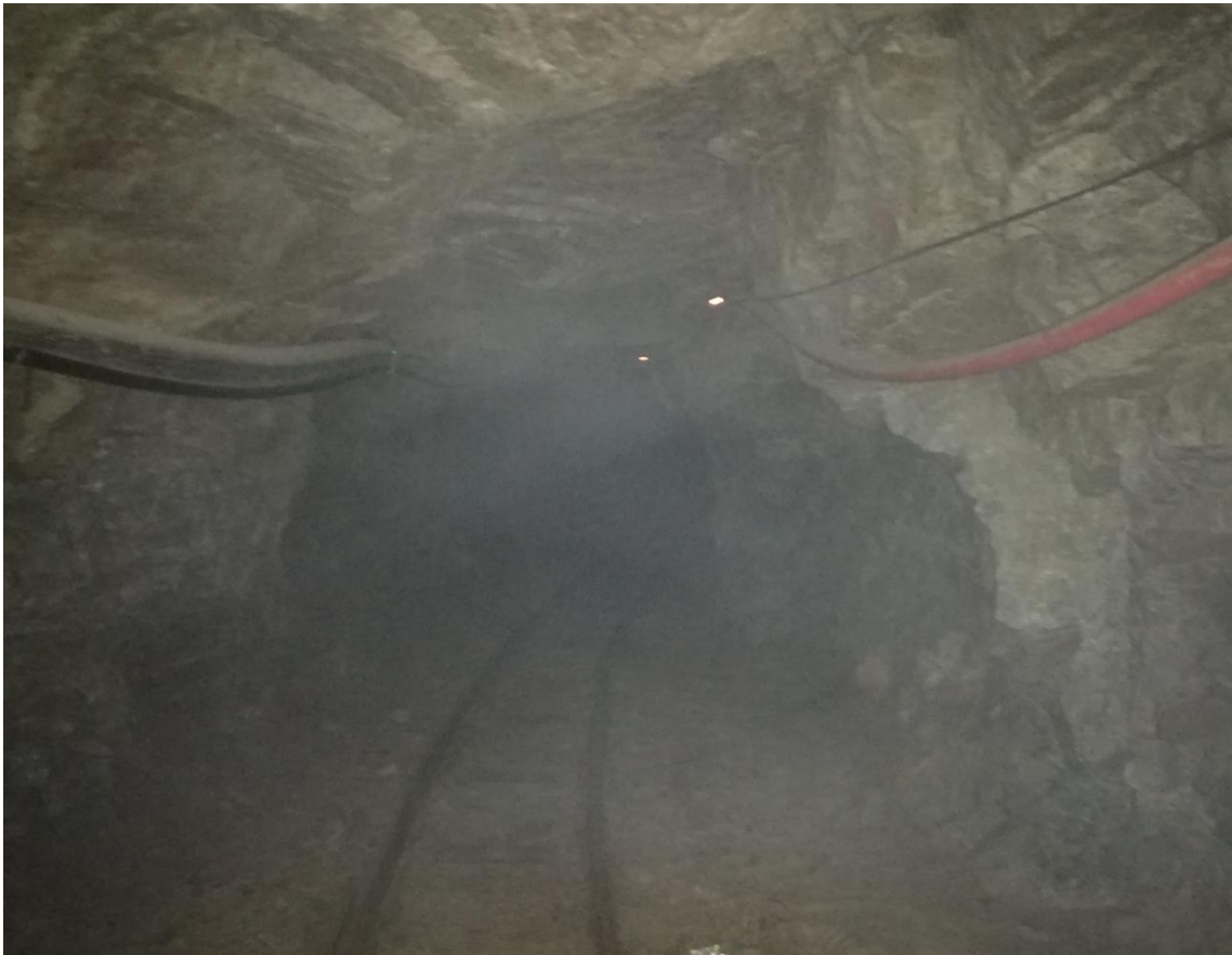
Figura 39: Presencia de colchones de humo en la Galería 508 E.
