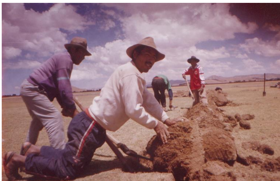
Figura 28. Extracción de Ch'ampas con ayuda de dos palas.
