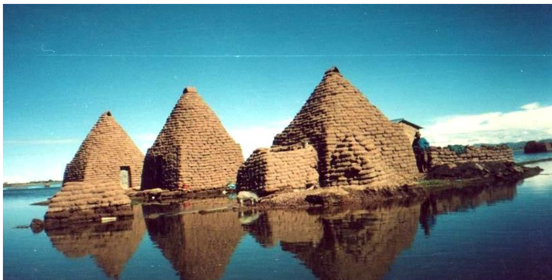
Figura 76. Estabilidad de los Putucos expuestos a inundaciones.
