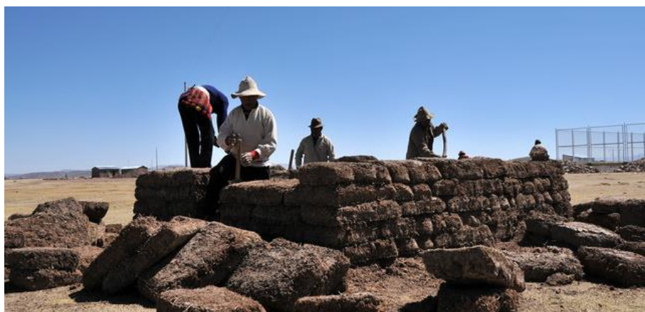
Figura 17. Utilización de las Ch'ampas para construir un Putuco .
