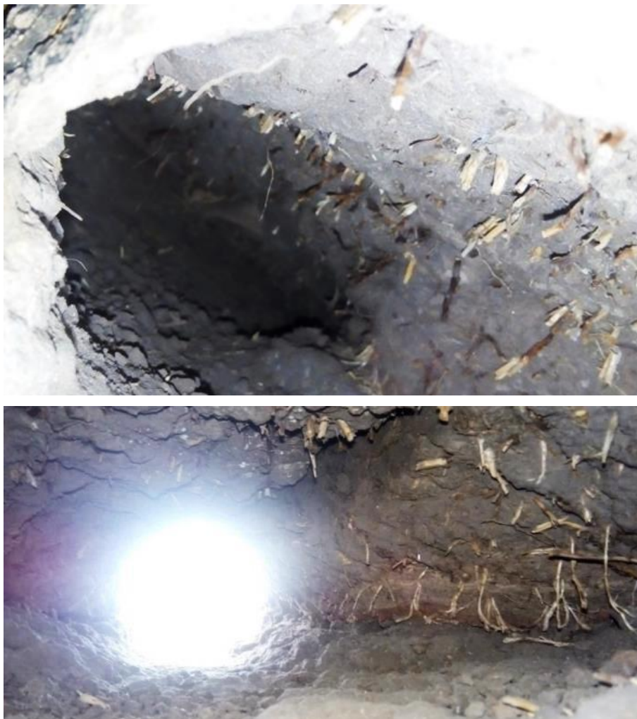
Figura 70. Vista de las raíces dentro de un muro construido con Ch'ampa .
