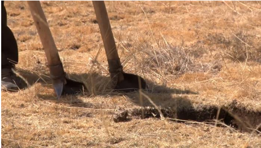
Figura 14. Extracción del bloque natural denominado Ch'ampa .
