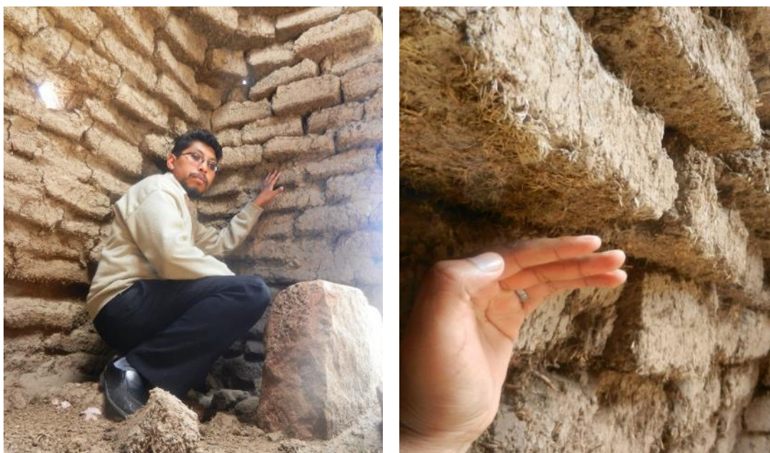
Figura 85. Disposición constructiva empírica de viviendas tipo Putuco.
