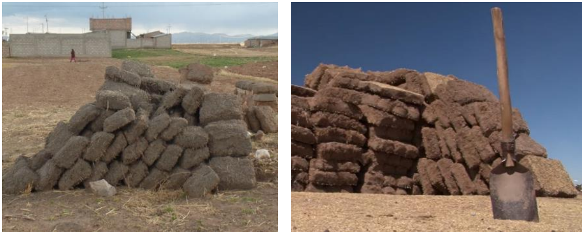
Figura 16. Almacenamiento y secado de la unidad de Construcción Ch'ampa .
