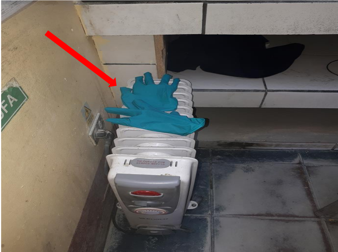
Figura 4.13: Mal uso de los guantes por la empresa Ramis. Fuente: Mina San Rafael - Minsur S.A.
