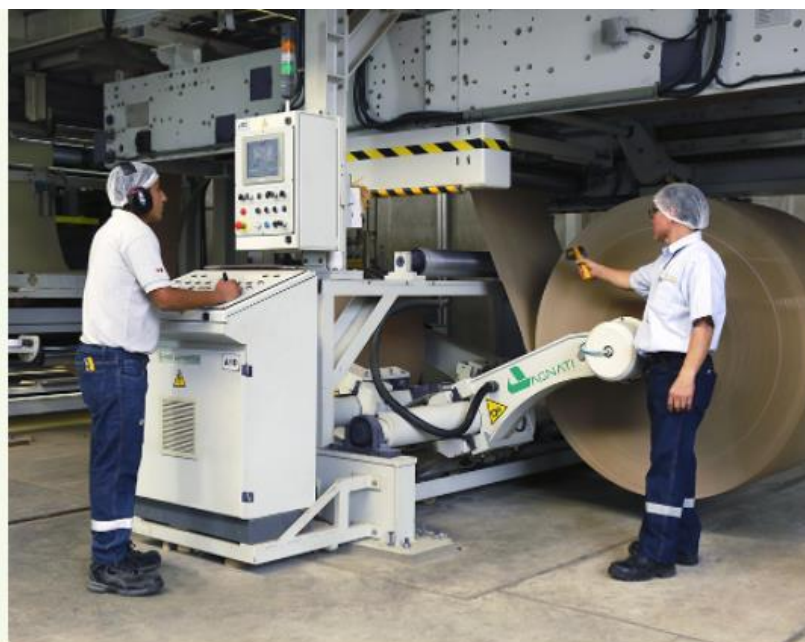
Figura 5.16. Maquinaria de Innovapack S.A.
