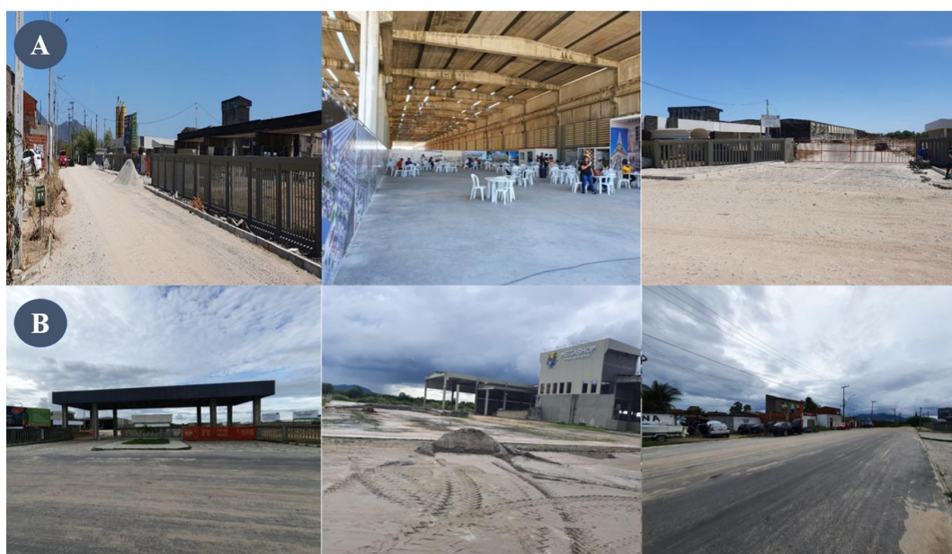
Figura 3. Avanços das obras no MSMN
