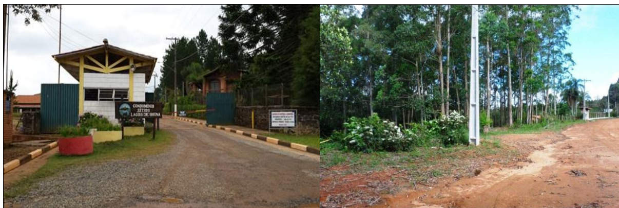
Figura 10 - Imagens ilustrativas de estruturas em condomínio de chácaras.
