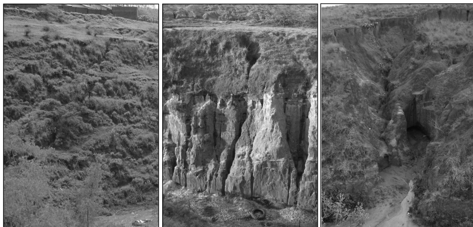
Figuras 2a, 2b e 2c – Encosta com abatimentos em nível, talude erosivo com forte inclinação e ravinação lateral, respectivamente
