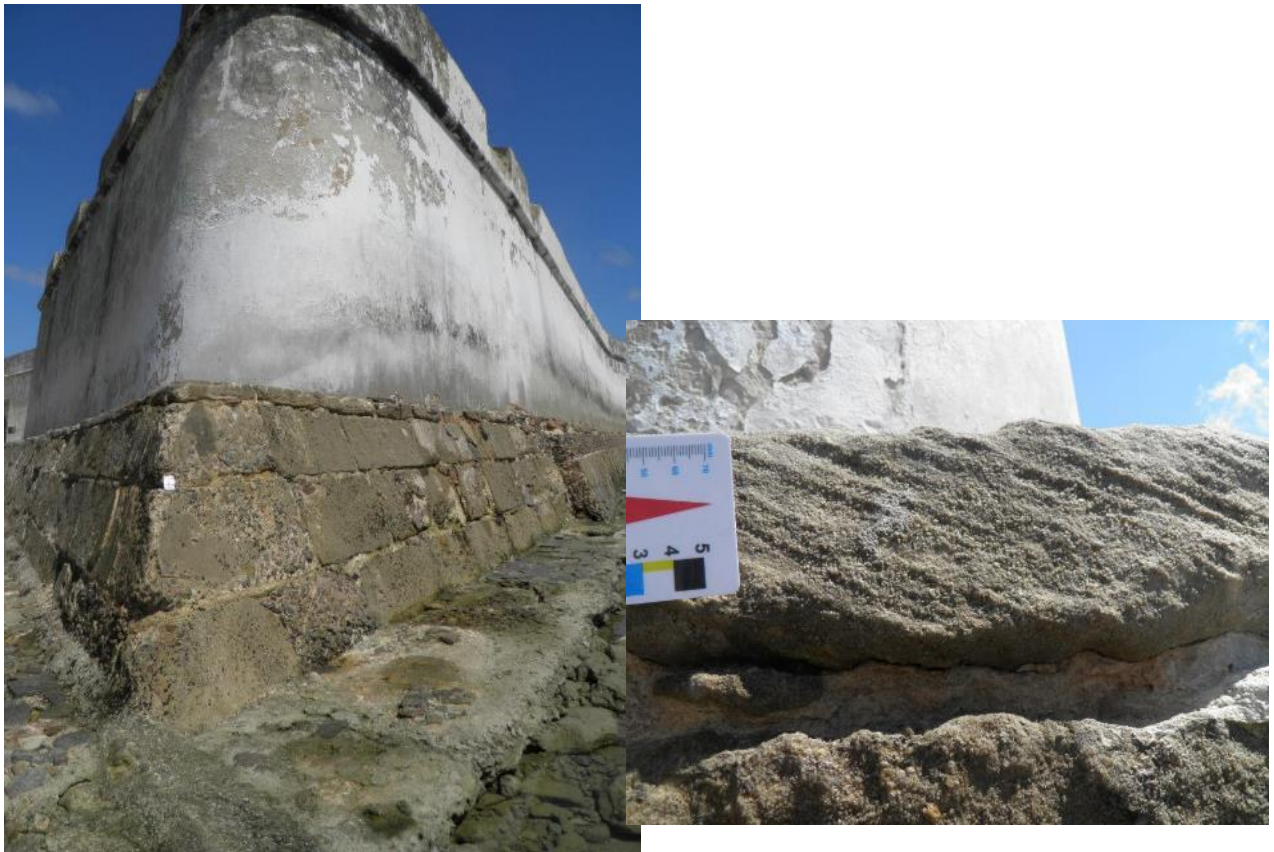
Figura 10 – Blocos de arenitos provenientes dos recifes utilizados para compor a fortificação (à esquerda). Em detalhe (acima) bloco de arenito com estratificação cruzada e granulometria fina a média. Fotos: Marcos Nascimento.
