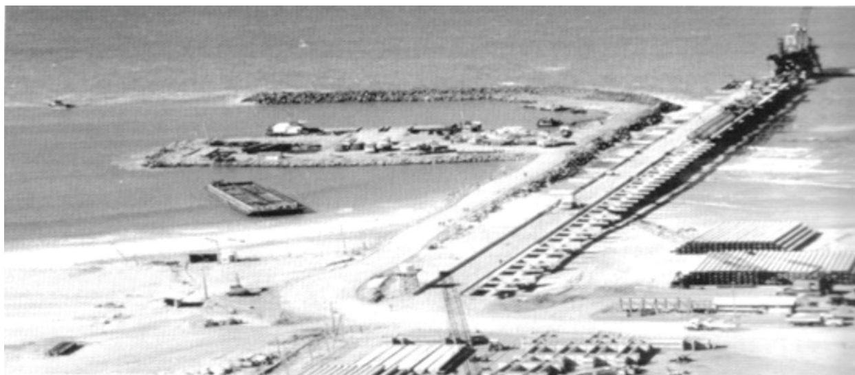
Foto 1. Dique seco, aterramento lateral e início da implantação do píer com a fixação das estacas de ferro e consolidação seqüencial do acesso ao quebra mar. Terminal de Embarque Provisório.
