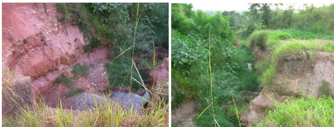
FOTO 1. Imagens da ravina localizada próxima à estrada de ferro.
