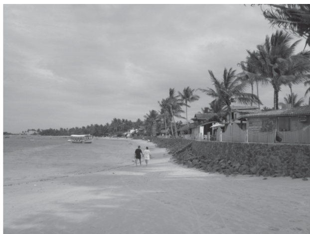
FOTO 5. Obra de contenção à erosão em Morro de São Paulo.
