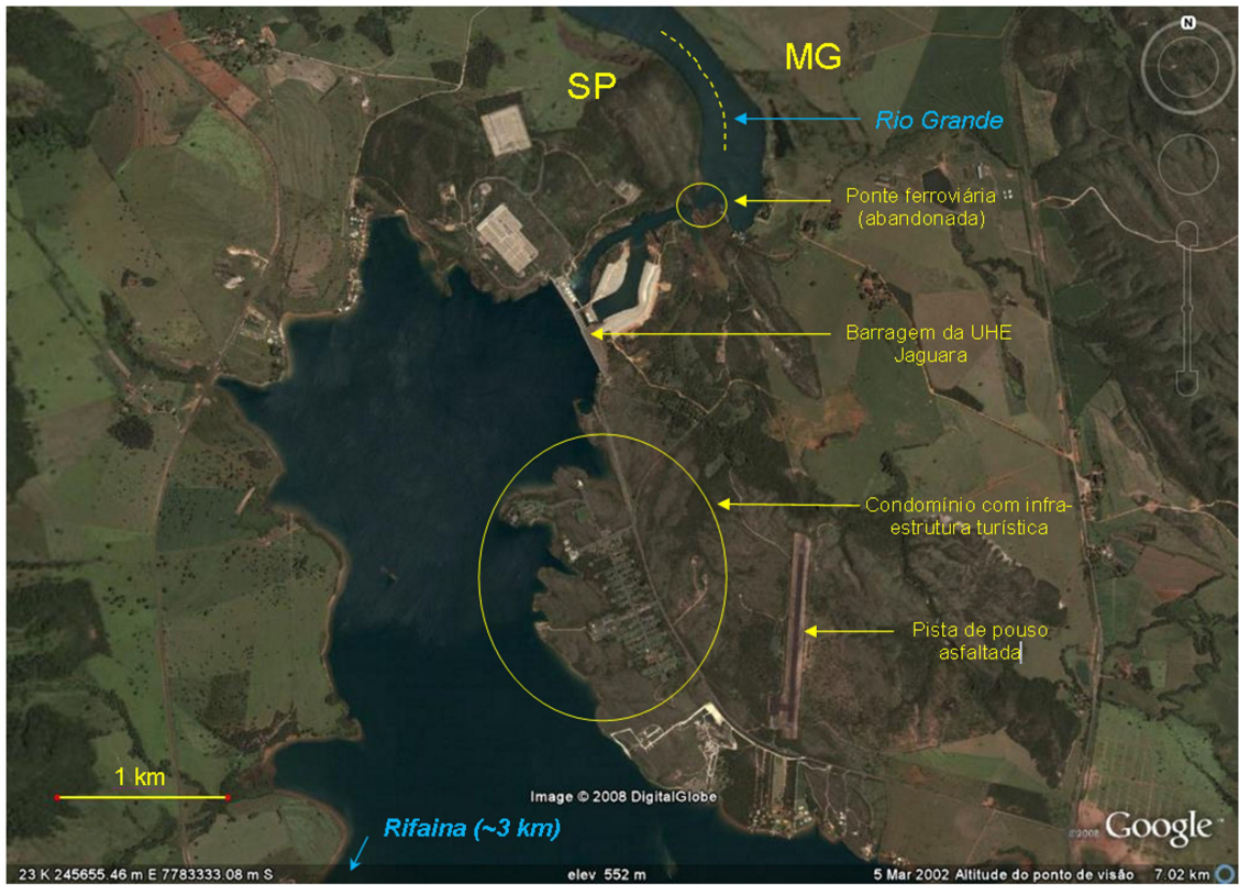
FIGURA 4. Porção jusante da Represa de Jaguará e principais instalações de entorno. As coordenadas UTM do canto superior esquerdo encontram-se marcadas no rodapé.
