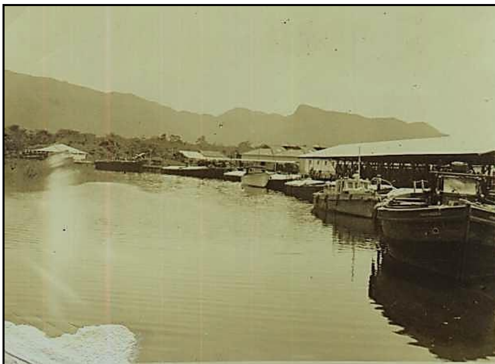
Foto 1 - Lanchas e chatões no porto da Fazenda Serramar, Caraguatatuba/SP.
