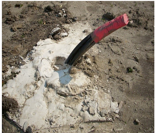
Abbildung 13: Eingebaute Erdwärmesonde
