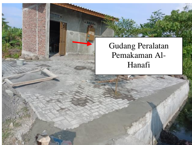
Gambar 8. Hasil Pemasangan Paving Block sebagai Area Parkir dan Jalan
