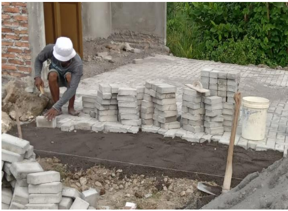
Gambar 7. Pemasangan Paving Block dengan Pola Herringbone 90 0
