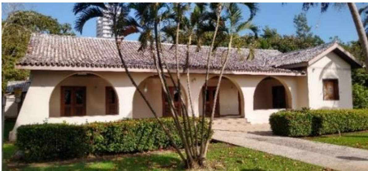
Figura 4. Fachada principal da Casa do Governador.
