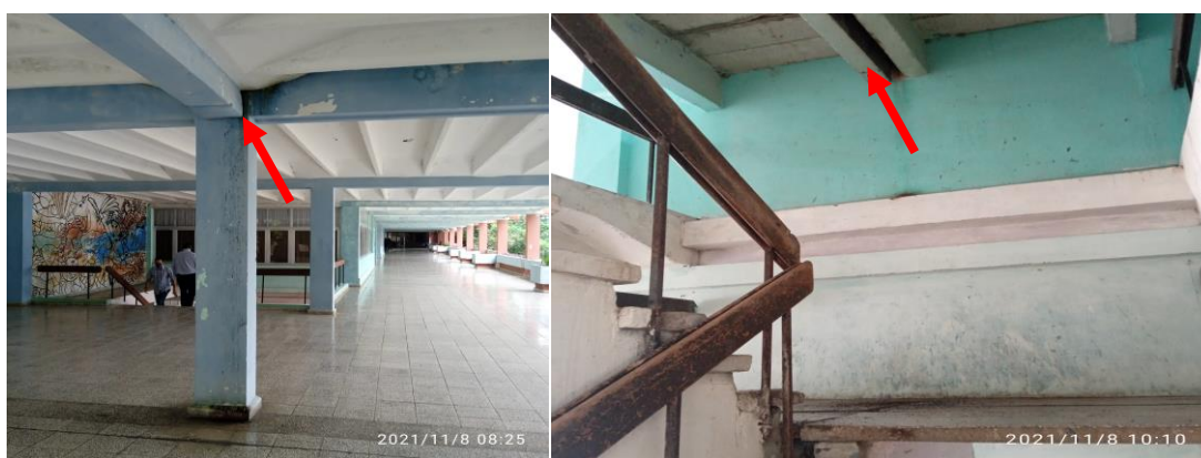
Figura 3. Pasillo central en dirección del comedor y escaleras en la Residencia estudiantil
