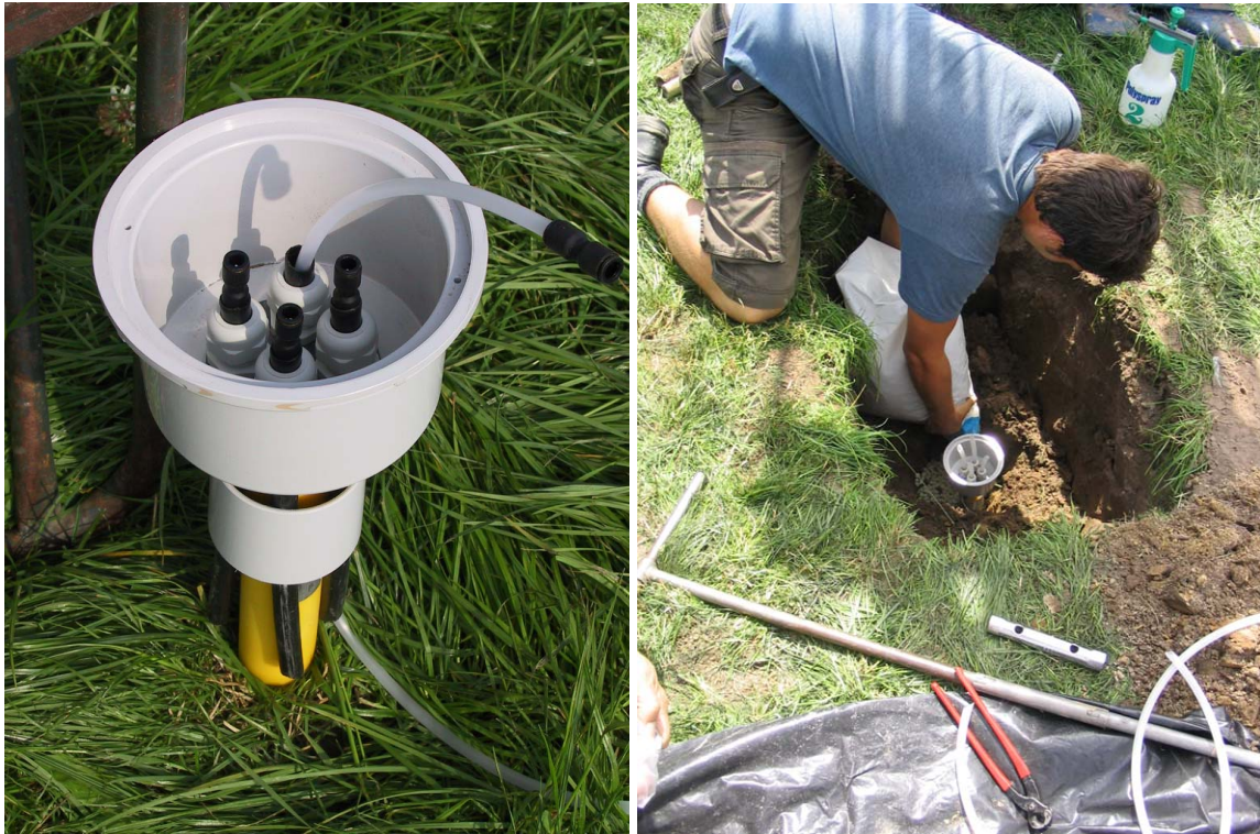
Figuur B8.2 Afwerkpot met gele marker (links) en het aanbrengen van bentonietkorrels onder de afwerkpot van de Direct Wells (rechts).
