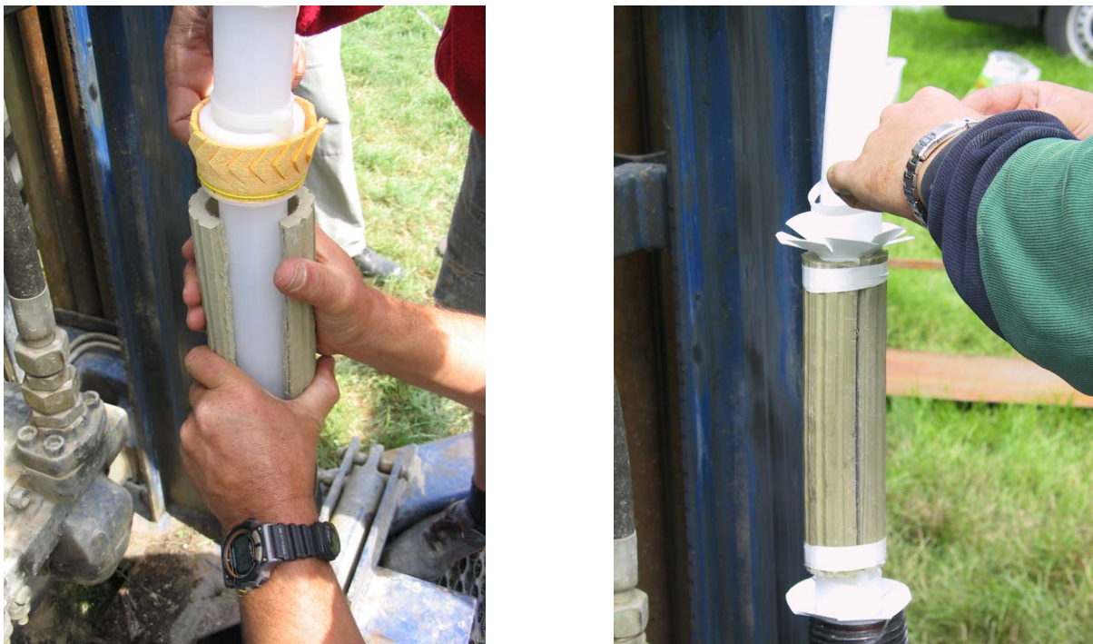
Figuur 3.9 Installatie van de Multi-Channel Well met bentoniet en het oude type scheiding (links) en met de nieuwe geoptimaliseerde witte kragen (rechts)
