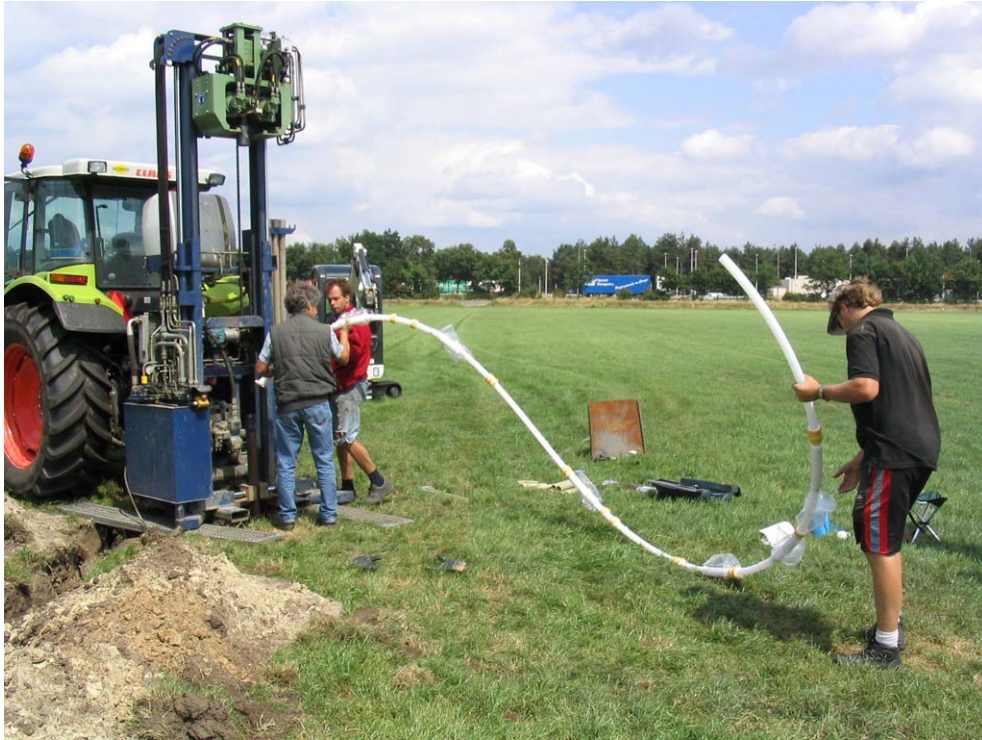
Figuur B2.6 Installatie van de Multi-Channel Well in Maarheeze (1/57E0336)
