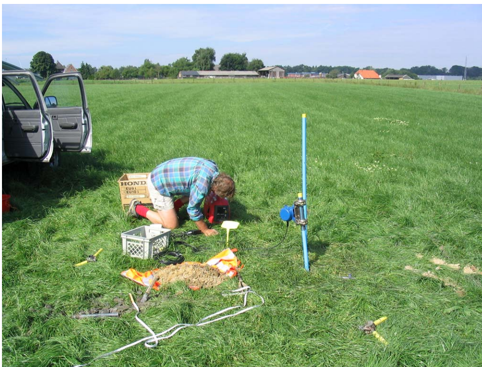
Figuur 3.8 Filterplaatsing met trilmotor op filterlans (optimalisatie Van der Staay-methode, Nieuweroord)
