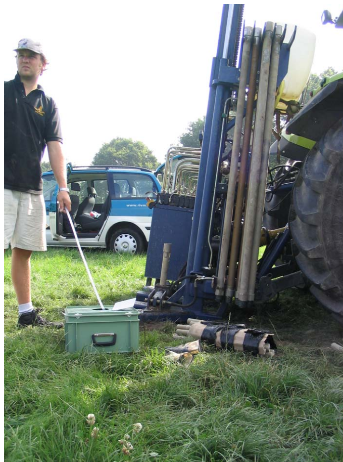
Figuur 2.5 Plaatsing van het bovenste Direct-Well-filter onder een hoek van 10 graden
