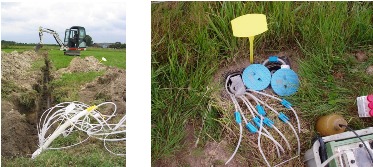
Figuur 3.10 Afwerking naar de perceelsrand in Maarheeze. Links de gegraven geul richting perceelsrand, rechts de straatpotten voor de Direct Well (rechts) en de Multi-Channel Well (links) aan de perceelsrand
