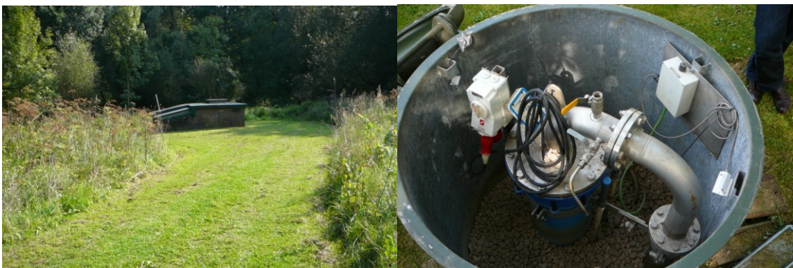
Foto 1 Winput in een waterwingebied en bovenaanzicht winput.
