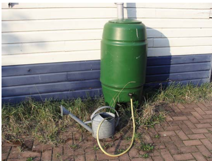
Opvang van regenwater van het dak in een regenton
