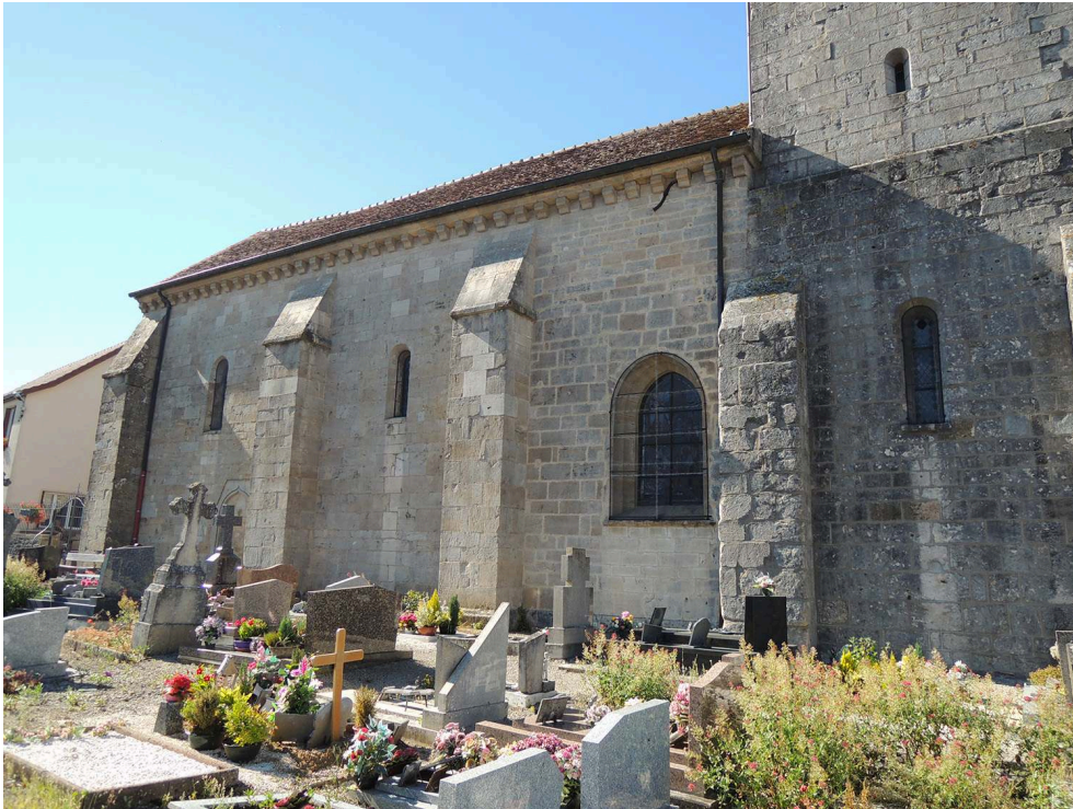
Fig. 3 – Église de Balesmes-sur-Marne (Haute-Marne), face sud extérieure, distinction des contreforts de la nef et de la travée sous clocher (cl. A. Jeannel).
