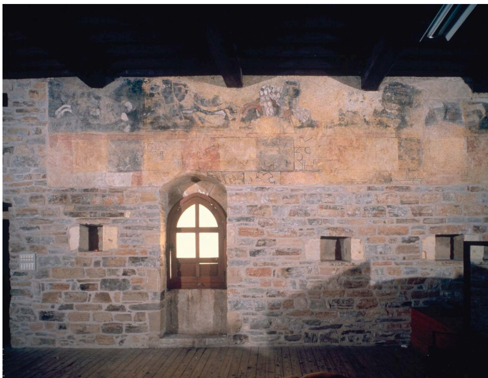
Cordes-sur-Ciel (Tarn), maison du Grand fauconnier ; deuxième étage, la cavalcade.
