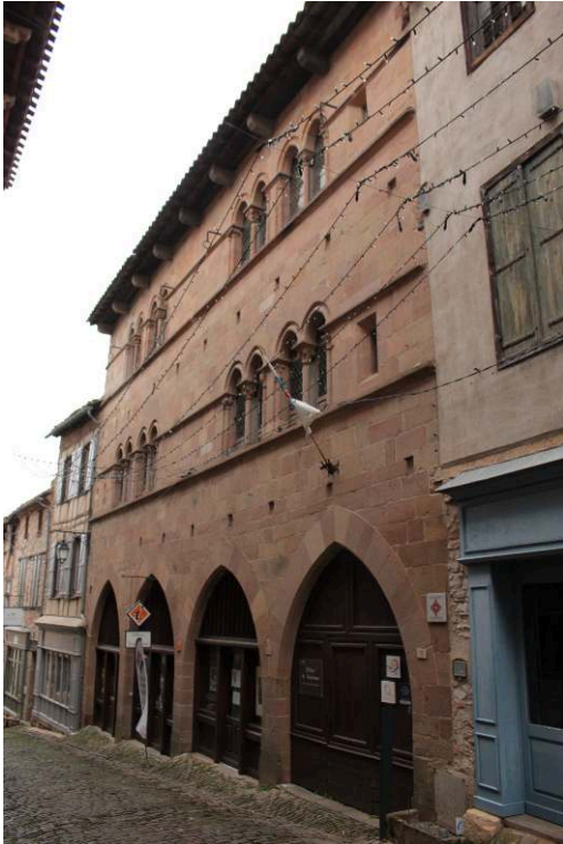
Cordes-sur-Ciel (Tarn), maison Gaugiran.
