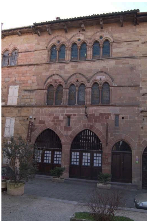
Cordes-sur-Ciel (Tarn), maison Prunet.
