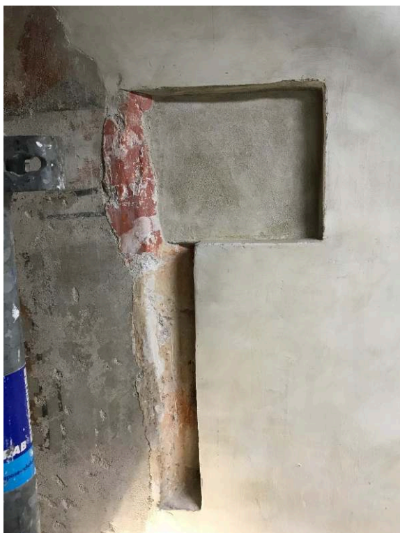
Lombez (32), cathédrale Sainte-Marie, actuellement église paroissiale. Mur ouest de la chapelle de l'Agonie avec le sondage prouvant l'existence d'un décor peint plus ancien.
