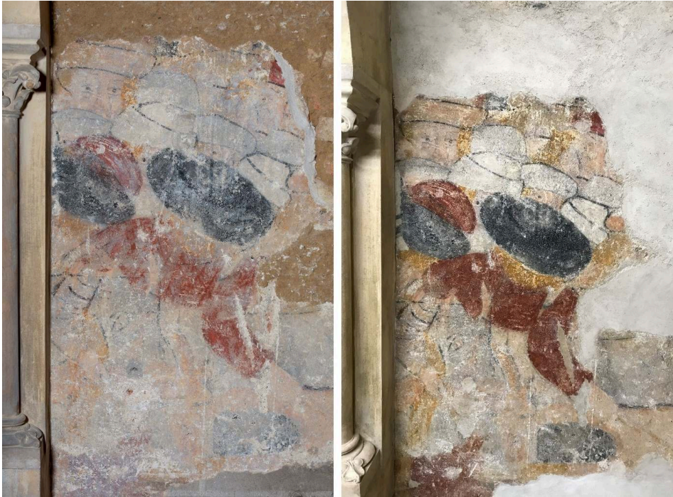
Lombez (32), cathédrale Sainte-Marie, actuellement église paroissiale, chapelle du Sacré-Cœur. Traitement des usures et lacunes.
