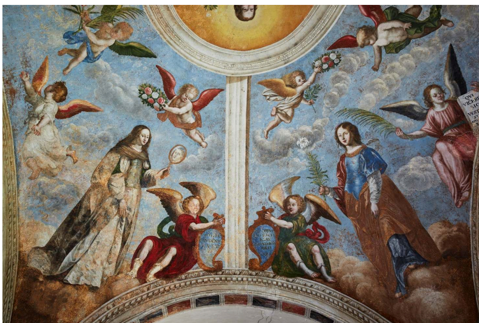
Cahors (Lot), chapelle du collège de jésuites actuellement collège Gambetta ; détail de la voûte de la chapelle Saint-Joseph
