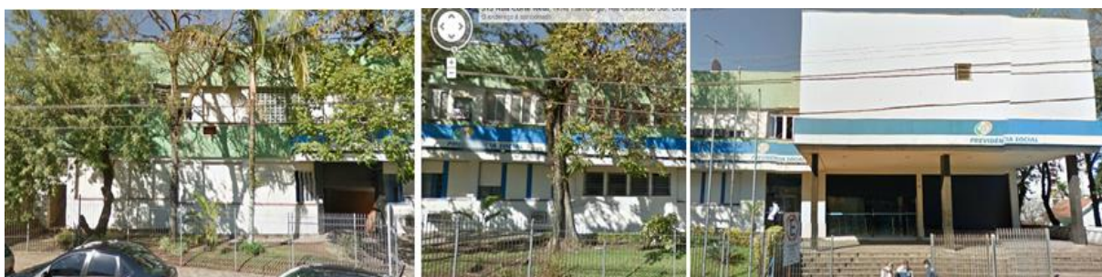
Figura 1: fachada Norte analisada
