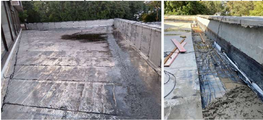
Figura 5 - Água empoçada sobre a laje e a execução do refazimento da impermeabilização no ponto P3.1
