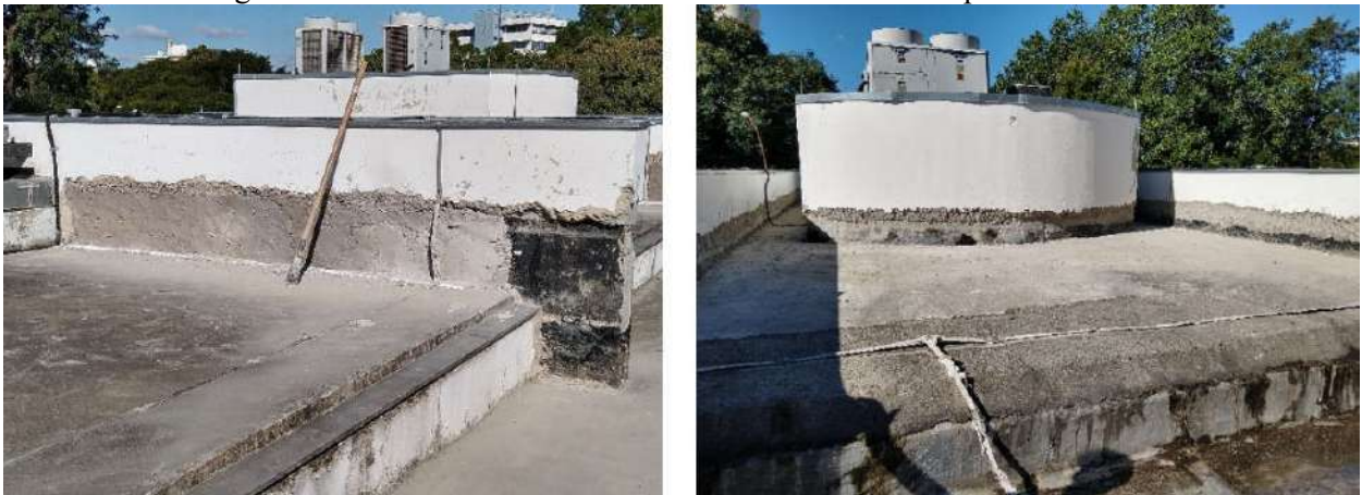
Figura 4 - Refazimento do revestimento sobre a manta nos pontos P2 e P4
