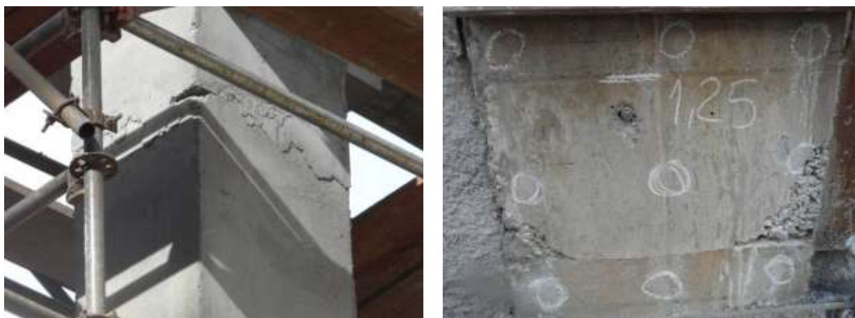
Figura 6: Detalhe da junta de concretagem de algum dos pilares analisados.
